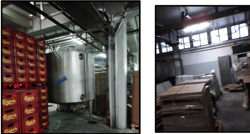
Figura 22 - Reservatório parado sem uso e espaço ocupado com equipamentos sem uso (Próprio Autor)
