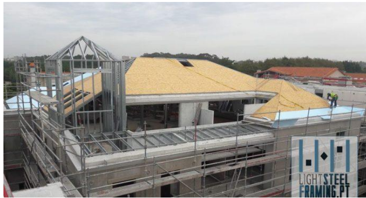
Figura 8 - Construção em LSF (fase de construção), [33].
