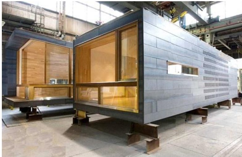
Figura 6 – Exemplo de uma construção modular [29].
