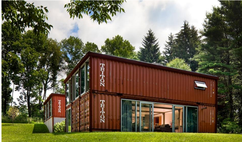
Figura 7 – Habitação construída a partir de contentores marítimos [31].
