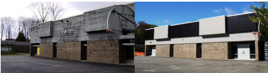
Figura 19 - Ginásio escola em Bedford, Nova Iorque (à esquerda: edifício original; à direita: integração de coletores solares a ar não envidraçado no edifício) [77].
