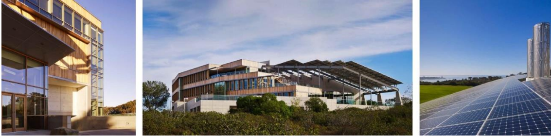
Figura 22 - Edifício La Jolla (adaptado de [90]).
