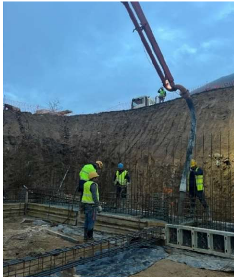
Figura 11 – Betonagem com bombagem da sapata contínua (Ribeiro, Carolina, 2023)
