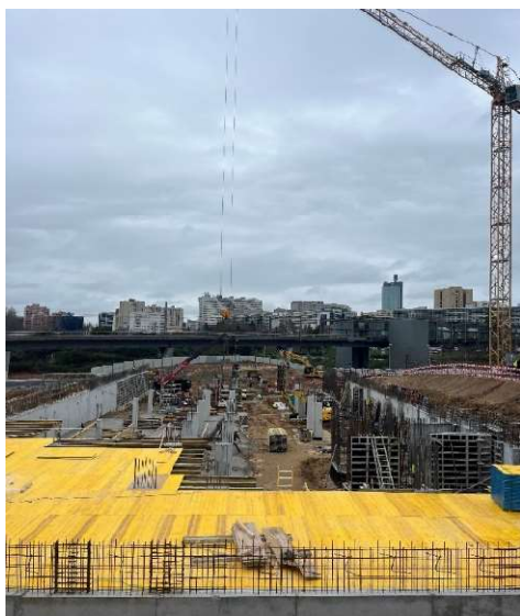
Figura 12 – Assoalhamento da Laje (Ribeiro, Carolina, 2024)
