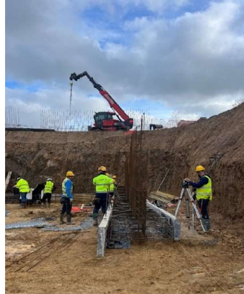
Figura 10 – Colocação de Armadura e Cofragem (Ribeiro, Carolina, 2023)
