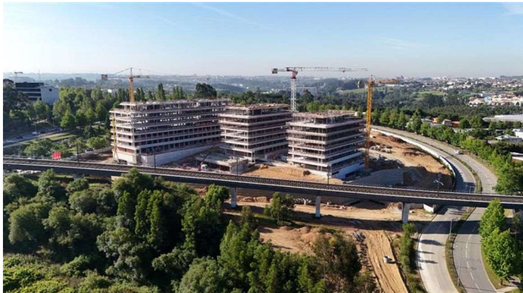
Figura 7 – Obra TUMAIA - Edifício H1, H3a, H3b (Foto c/ Drone. Fiscalização, 20.05.2024)
