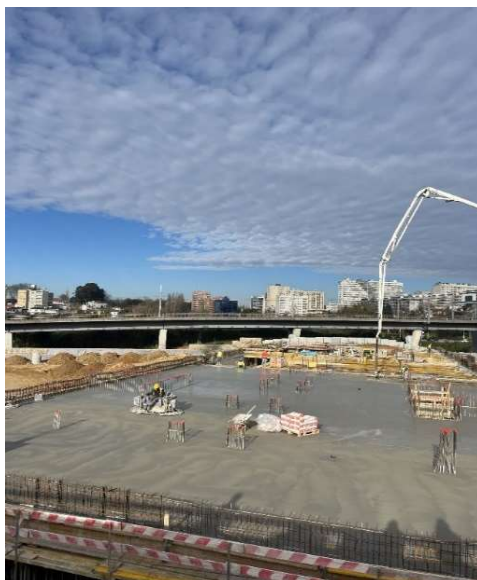
Figura 14 – Betonagem da Laje (Ribeiro, Carolina, 2024)
