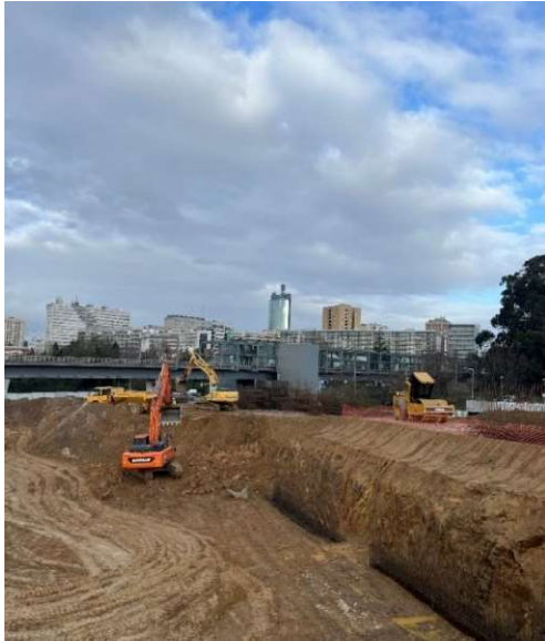
Figura 9 – Nivelamento, Marcações e Abertura de Caboucos (Ribeiro, Carolina, 2023)
