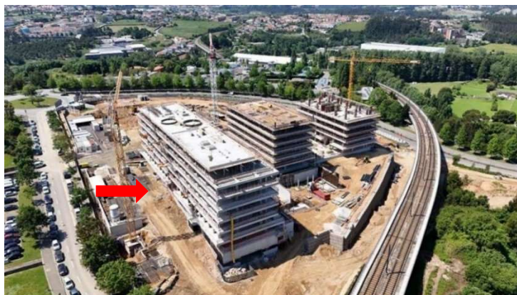
Figura 15 – Estrutura em Betão Armado do Edifício H1 (c/ Drone, Ficalização, 2024)
