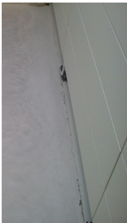
Figura 5.19 – Pavimento com aberturas.
