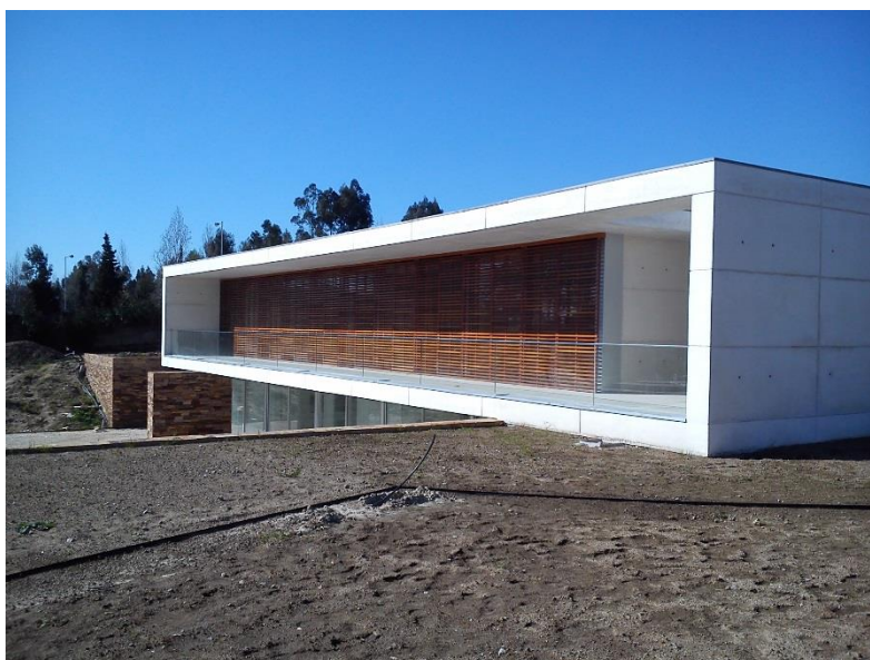
Figura 5.4 – Vista lateral do Lote 12.
