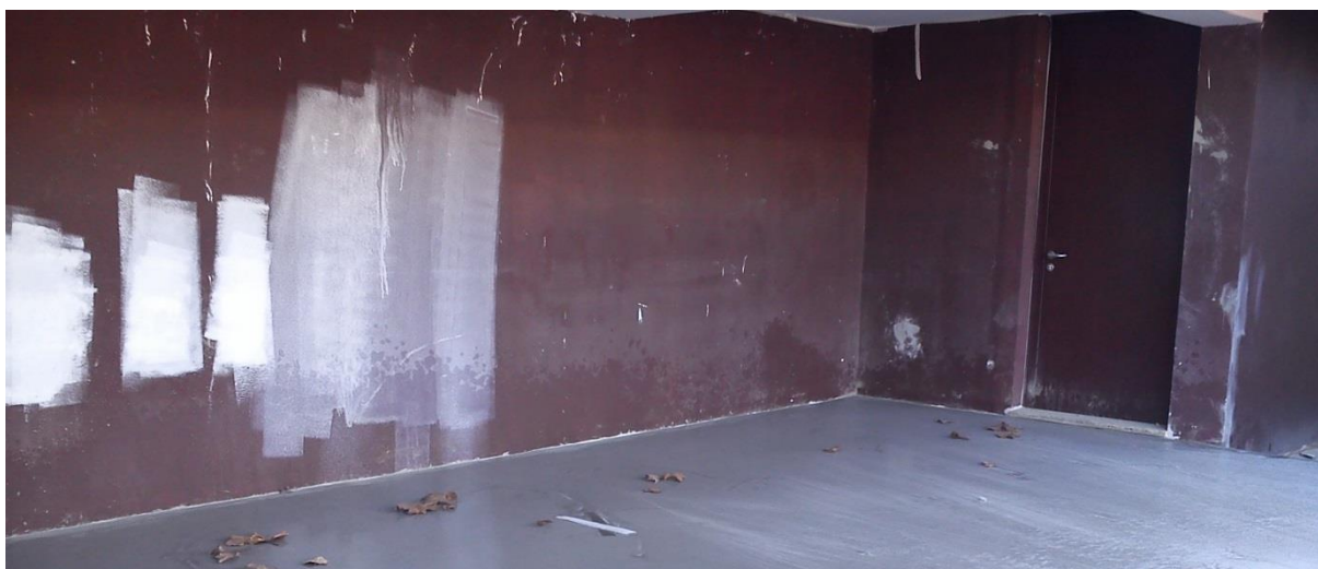
Figura 5.17 – Pavimento e paredes da garagem por terminar.
