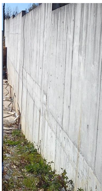
Figura 5.11 – Muro de meiação por concluir.
