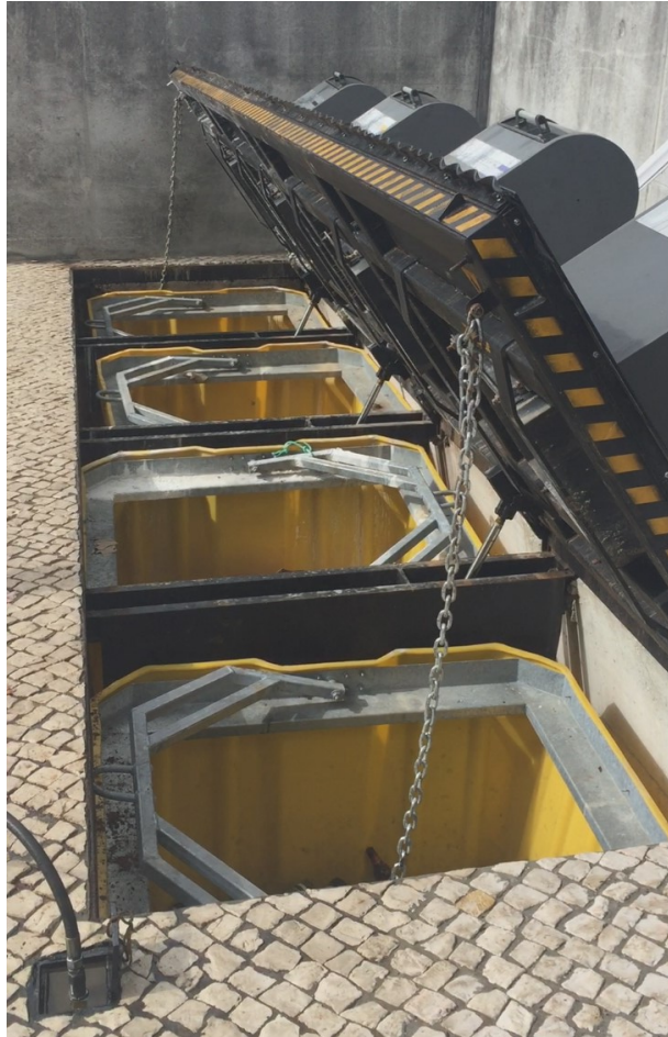
Figura 62 - Momento da abertura do HS4 através de cilindros hidráulicos ligados à tampa.
