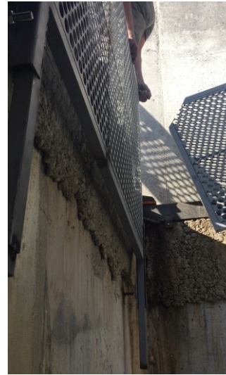
Figura 103 - Instalação da barreira lateral.
