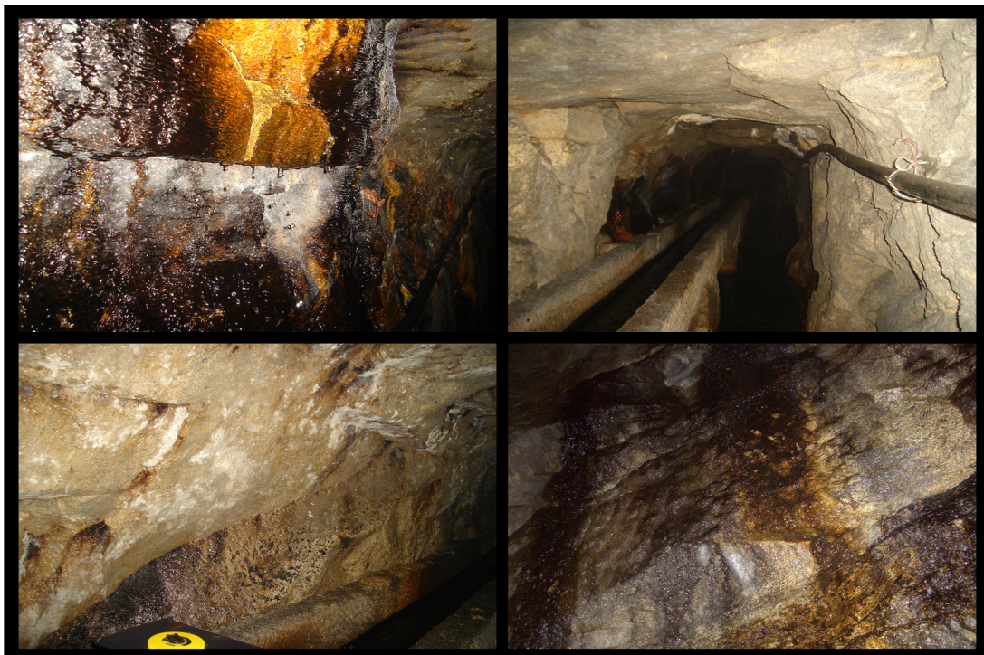
Figura 38: Aspeto do maciço rochoso no setor 2 da galeria Carvalhido-Burgães.
