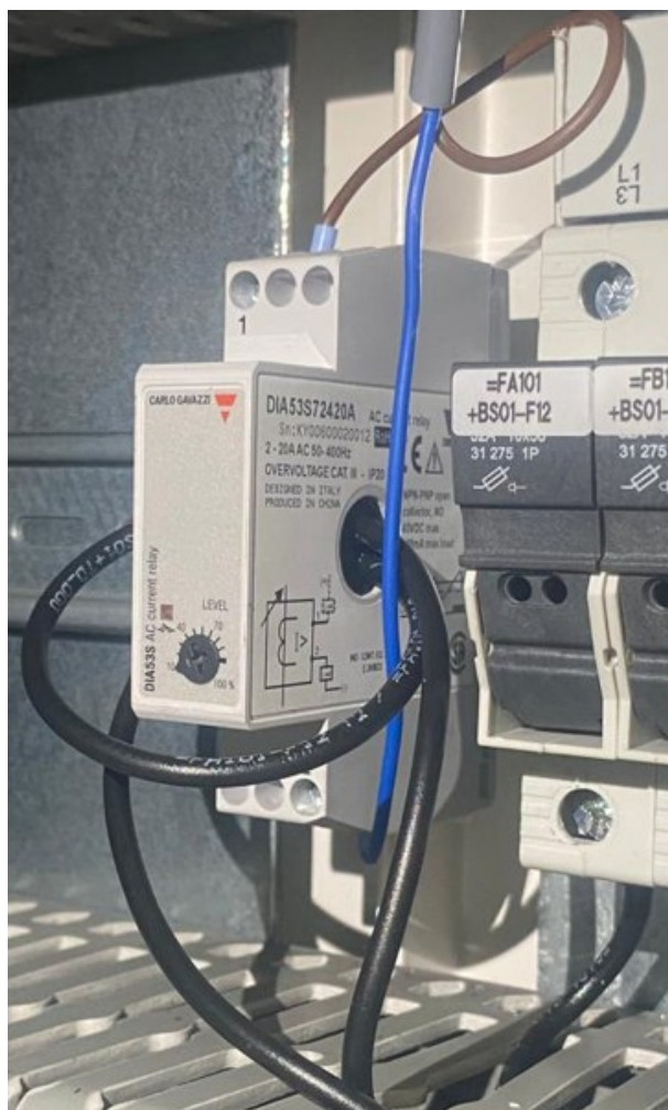
Figura 25 - Relé DIA53S72420AF de monitorização de intensidade de corrente elétrica
