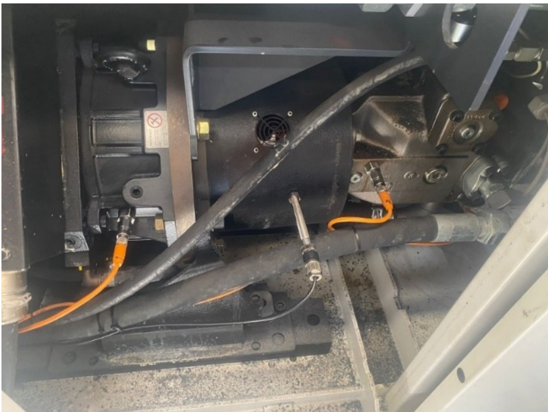
Figura 28 - Instalação dos acelerómetros A1, A2 e do sensor indutivo SI1
