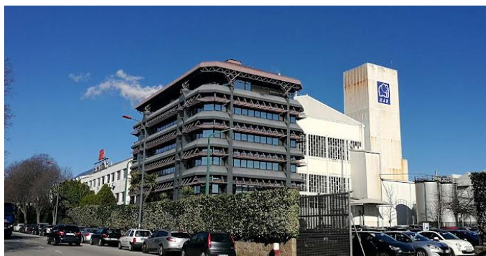
Figura 1.2.1 Instalações fabris da RAR Açúcar [imagem retirada de www.googlemaps.pt ]
