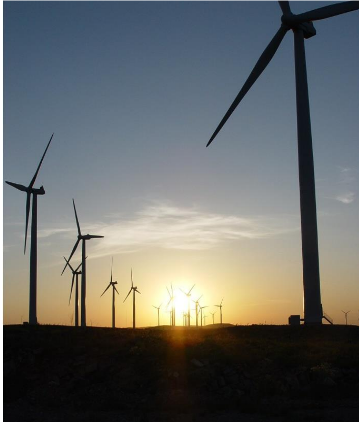
Figura 51: Foto do parque eólico que serviu de caso de estudo.
