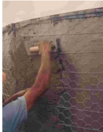
b) Primeira mão de argamassa
