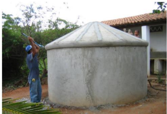
d) Cisterna finalizada e rejuntada
