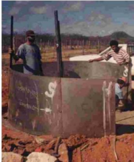
a) Construção das formas
