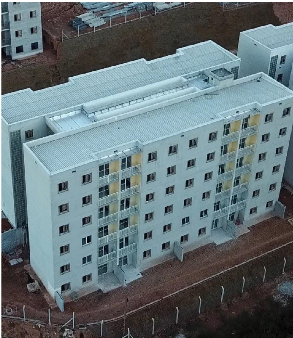
Figura 3.6 - Cobertura impermeabilizada e com telhas de fibrocimento ( Bevilacqua, 2018)
