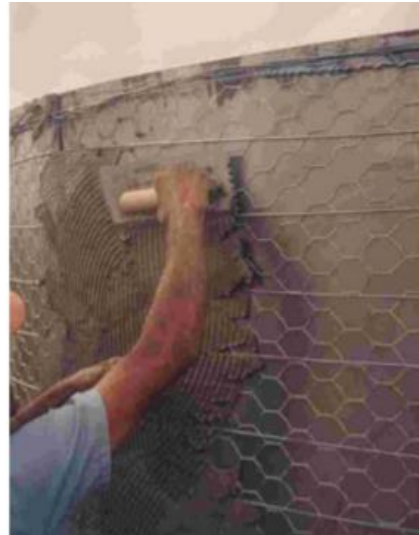
b) Primeira mão de argamassa
