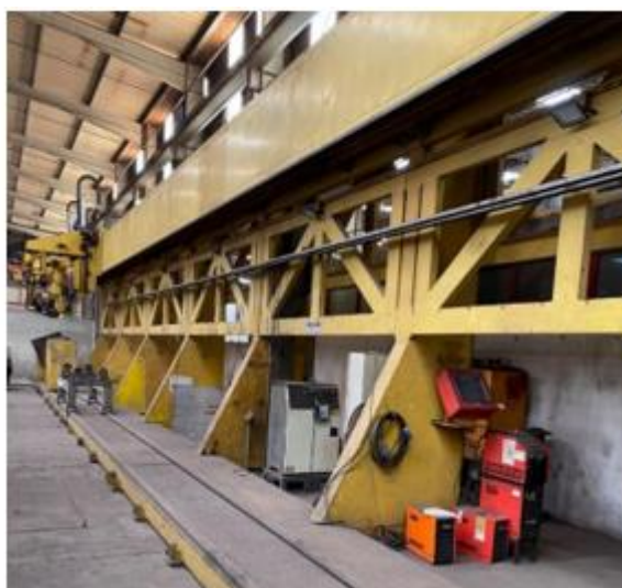
Figura 35 - Pórtico de soldadura existente em chão de fábrica
