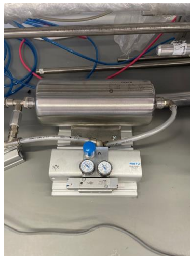
Figura 23 - Pressure booster , melhoria introduzida no sistema para permitir aumentar a pressão do sistema
