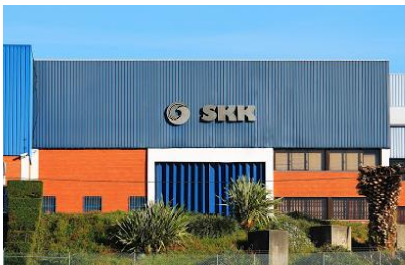
Figura 2 – Instalações da SKK localizadas em Matosinhos. Adaptado Google Earth
