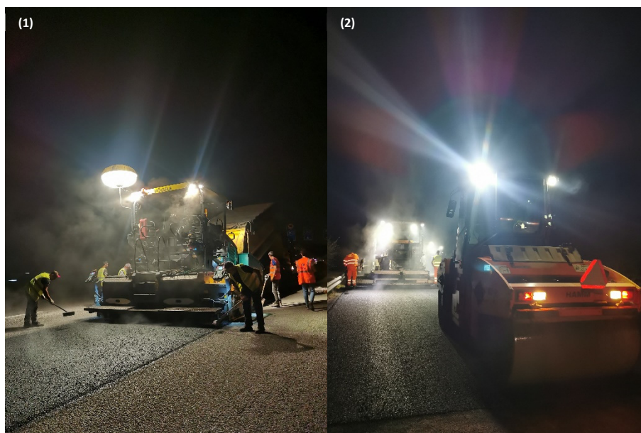
Figura 48 - Aplicação nos trechos piloto. (1)-M1.1-TP e M1.2-TP | (2)-M2.2-TP.
