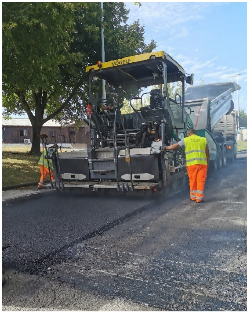
Figura 46 - Aplicação da mistura betuminosa nos trechos experimentais.
