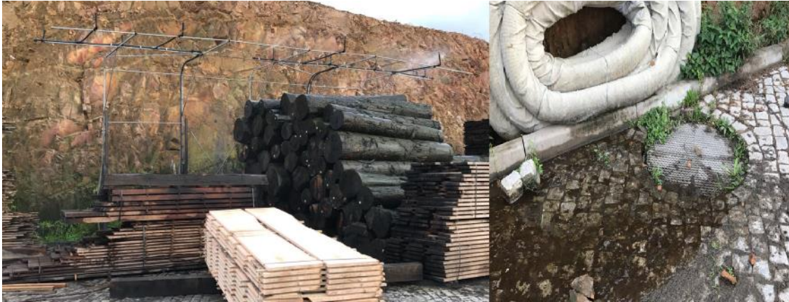
Figura 11. Rega de madeira e sistema de filtragem e recirculação da água.
