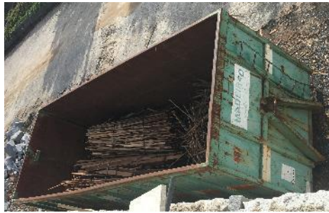
Figura 13 - Madeirão para depósito de resíduos de madeira.
