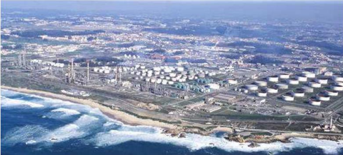
Figura 1 : Vista Panorâmica da refinaria do Porto
