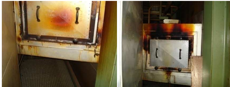
Figura 28 – Fotografias das condutas do ar de circulação
