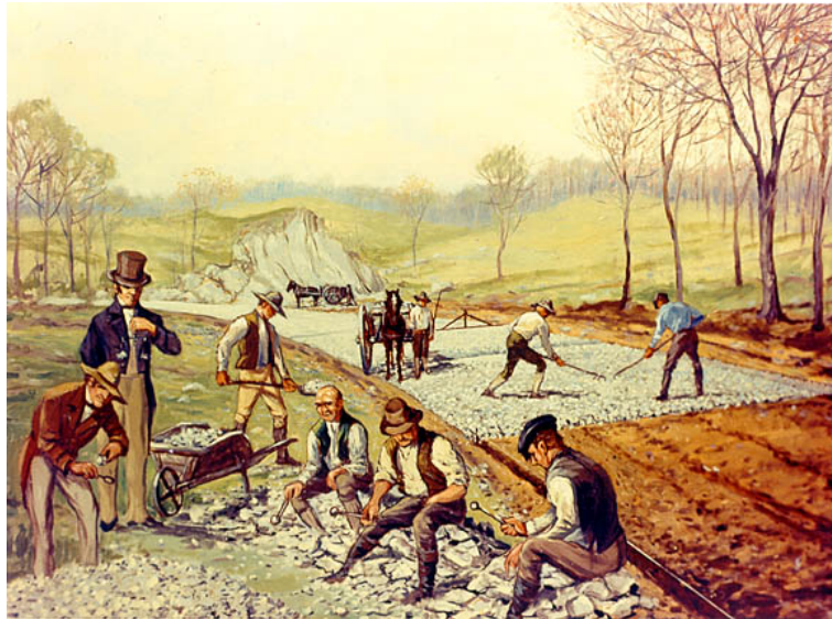
Figura 3.4: Ilustração da construção da primeira estrada macadam nos Estados Unidos, em 1823[8].
