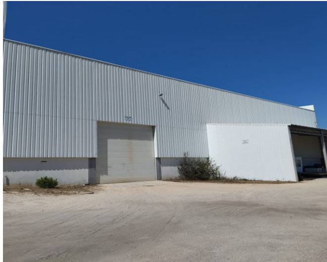
Figura 9 - Exterior pavilhão novo, usualmente denominado pavilhão Aço-carbono
