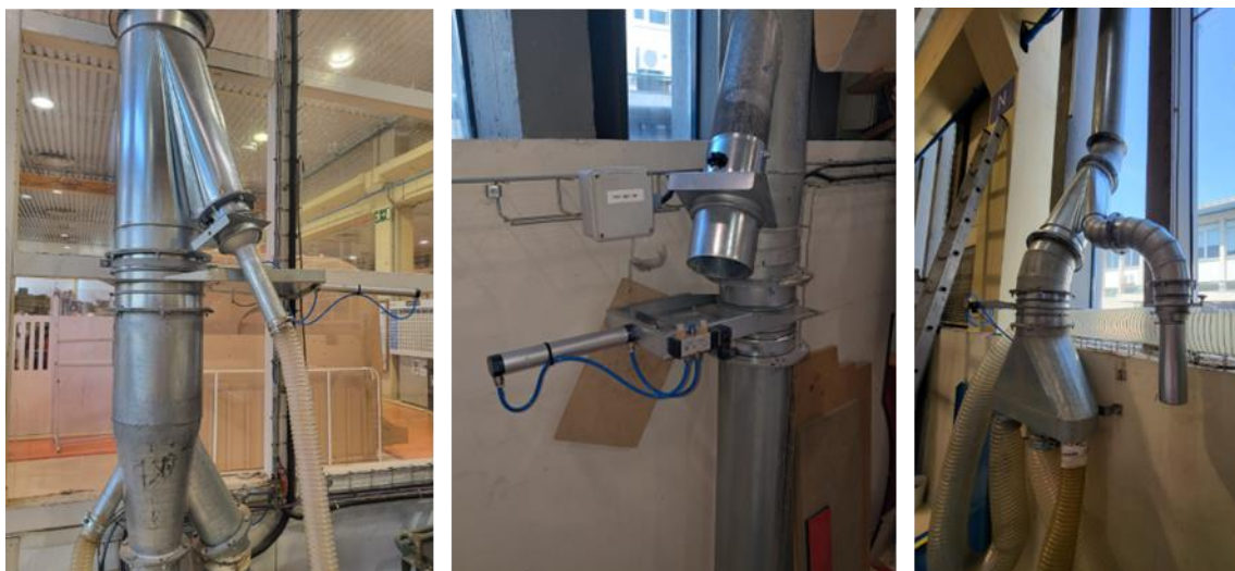
Figura 31 - Instalação de novas válvulas guilhotina em ramais de aspiração no Despoeiramento do Shell
