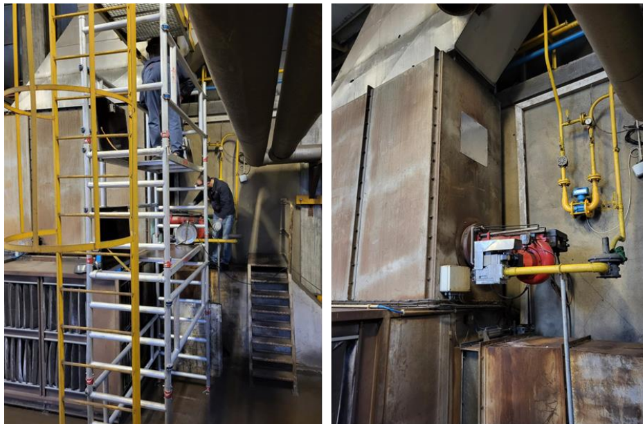
Figura 34 - Modificação da Cabine do PT após remoção da chaminé e adaptação do queimador
