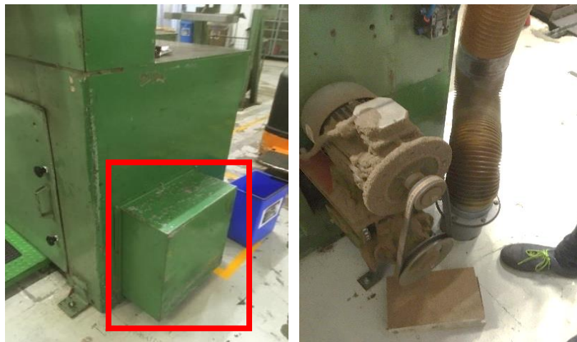
Figura 21 - Inspeção sem policarbonato
