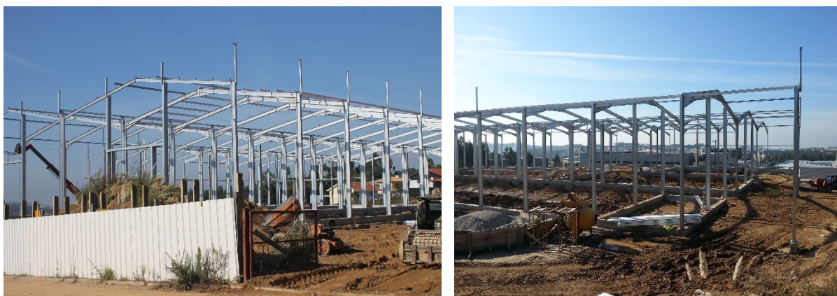
Figura 33 e 34 – Estrutura metálica das naves correspondentes ao CF4, CF5, CF6, CF7 e CF8
