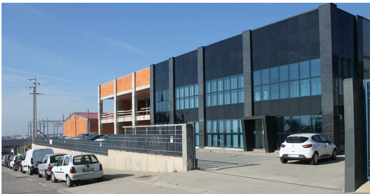
Figura 9 – Unidade de Fabricação de Tintas
