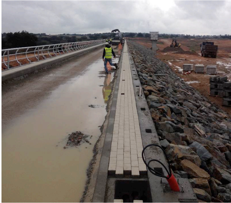
Figura 4.22 – Conclusão da instalação dos guarda-corpos
