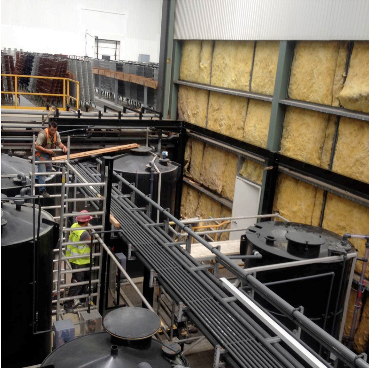
Figura 3.24 – Estrutura a ser montada no local
