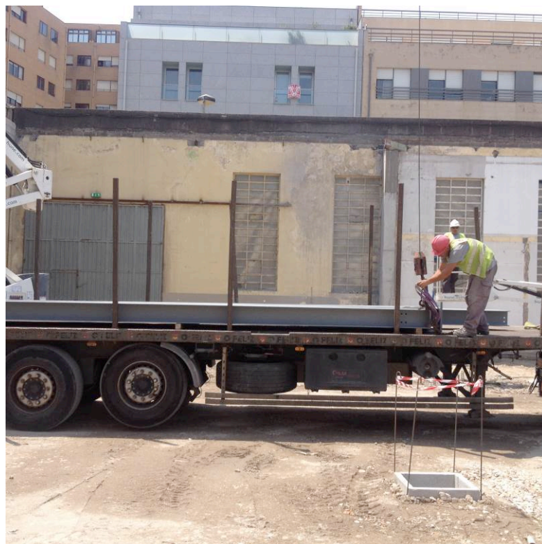
Figura 4.8 – Descarga dos perfis em obra
