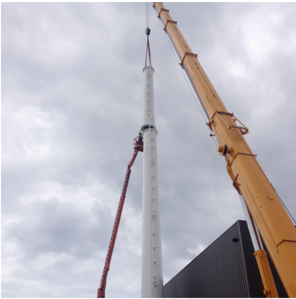
Figura 4.2 – União do segundo fuste ao primeiro
