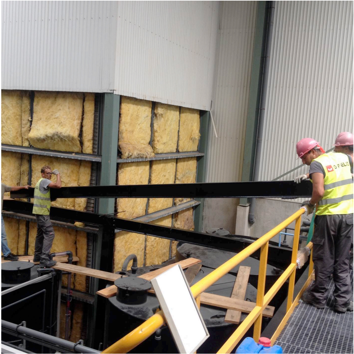
Figura 3.25 – Perfil a ser transportado manualmente
