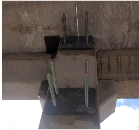
Figura 4.15 – Vista traseira da ligação aço-betão
