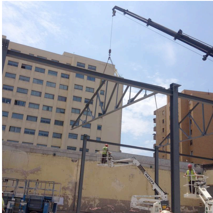
Figura 4.11 – Colocação dos contraventamentos
