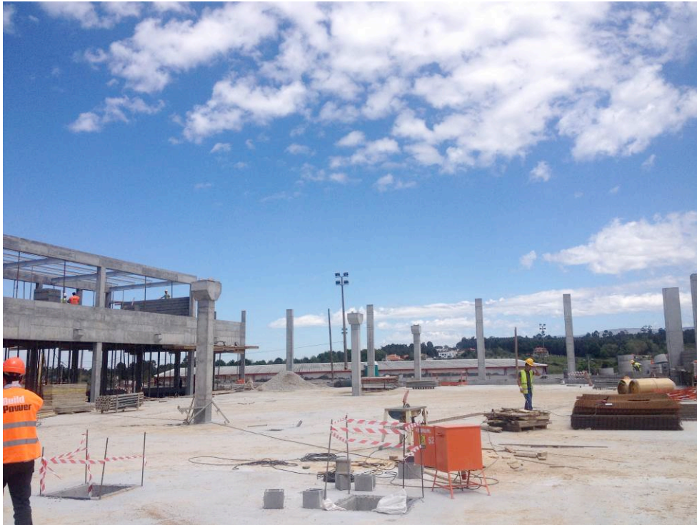
Figura 4.19 – Estrutura pronta para receber a estrutura metálica
