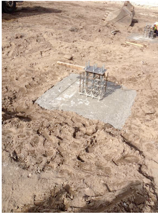
Figura 4.7 – Sapata betonada
