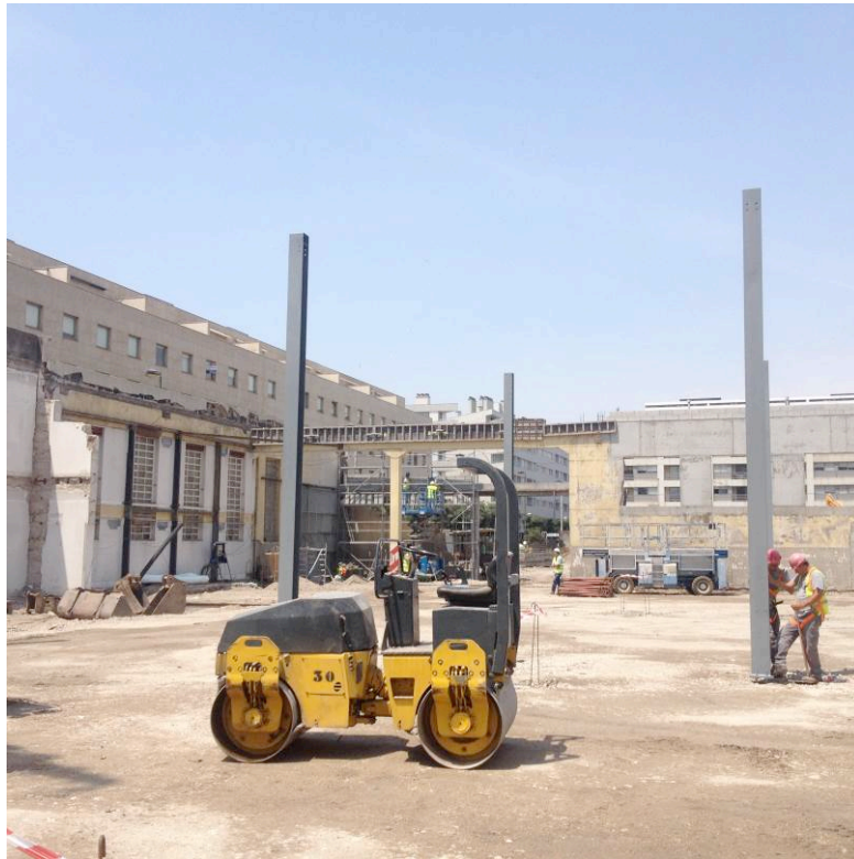
Figura 4.9 – Montagem dos pilares sobre as sapatas
