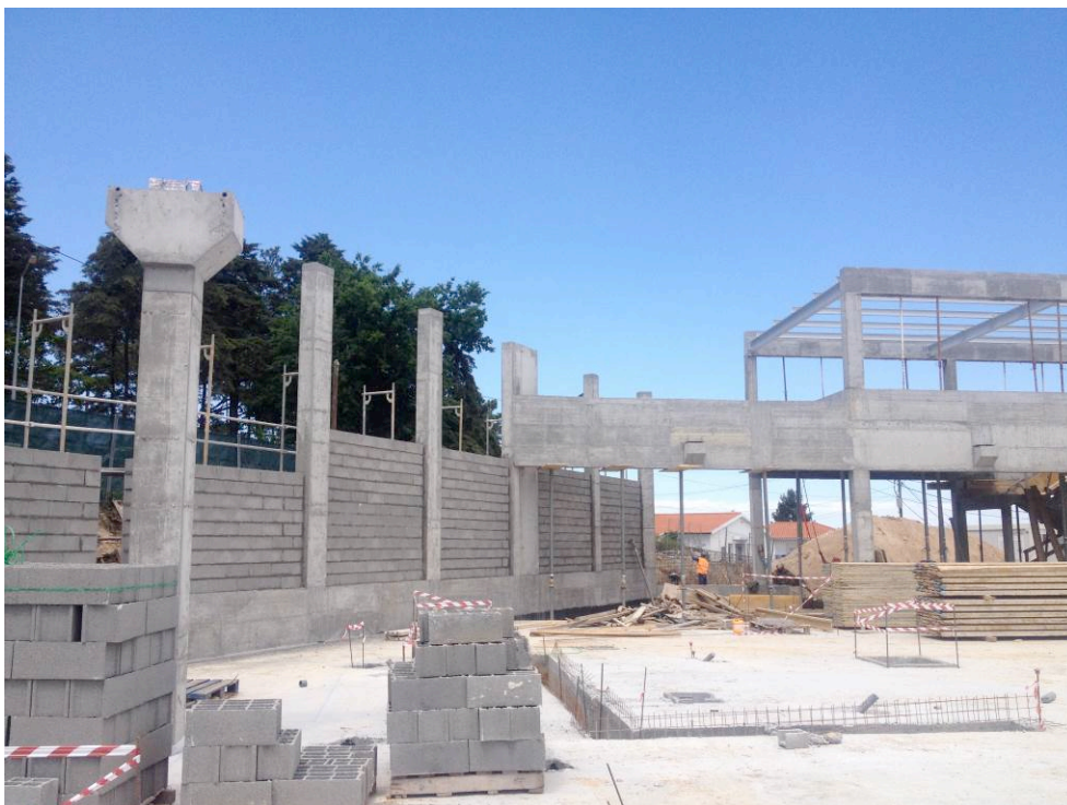
Figura 4.20 – Colocação de pilares pré-fabricados em betão
