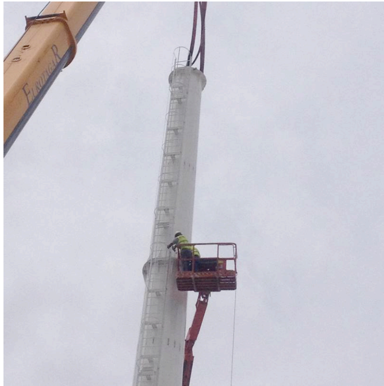
Figura 4.5 – Aperto da ligação aparafusada entre os dois fustes
