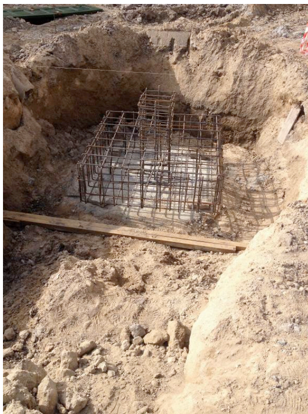
Figura 4.6 – Armadura da sapata
