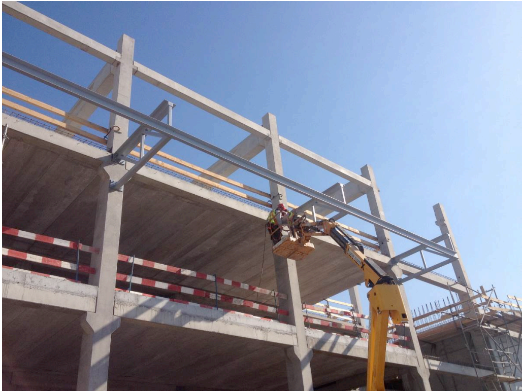
Figura 4.18 – Colocação dos travamentos
