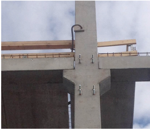
Figura 4.14 – Vista frontal da ligação aço-betão
