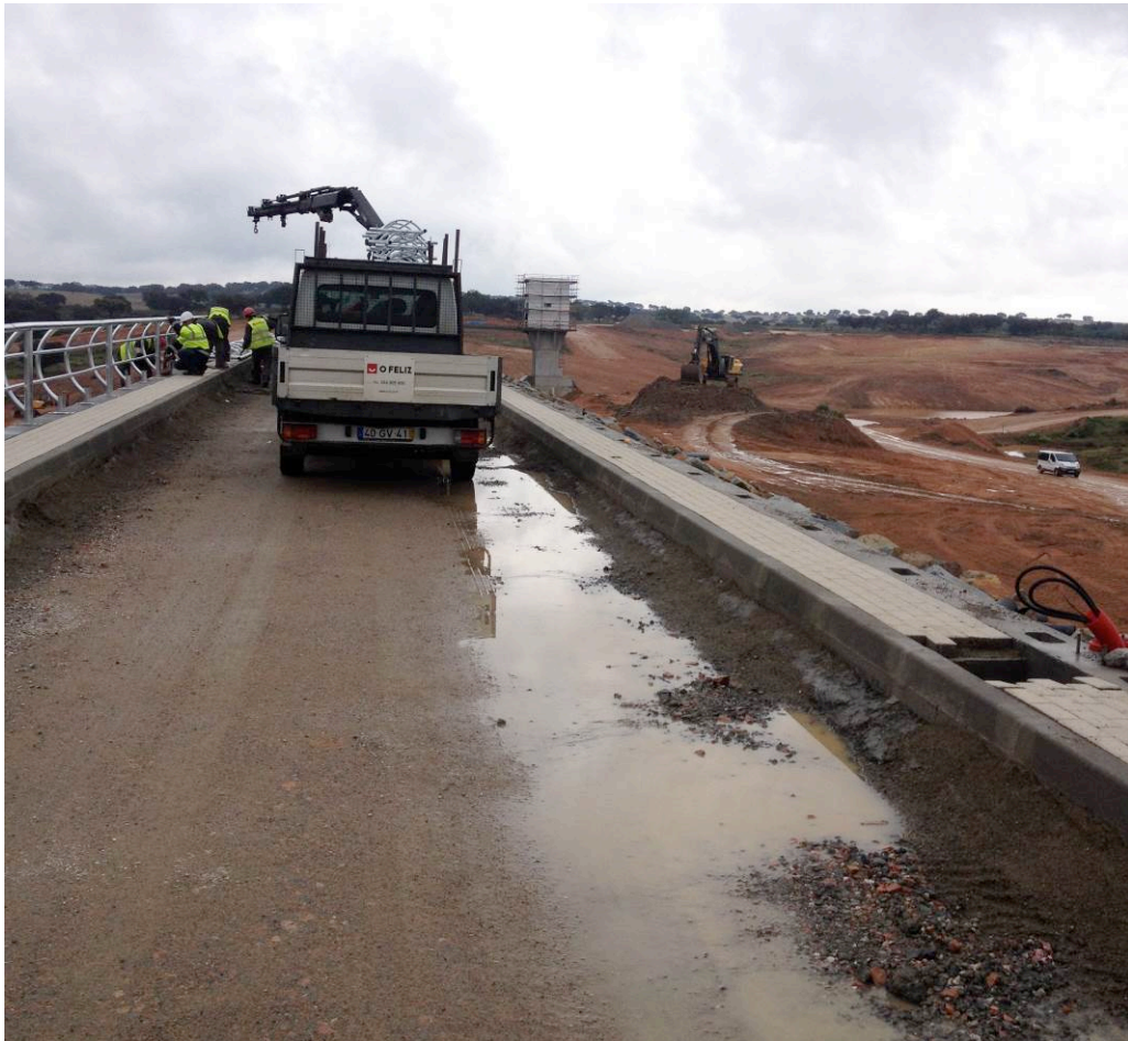
Figura 4.24 – Colocação dos guarda-corpos
