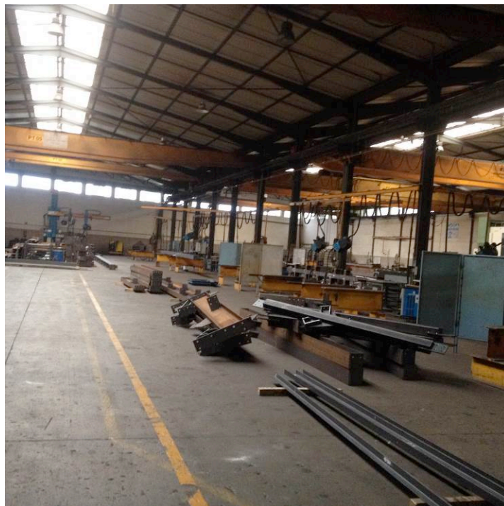
Figura 1.2 - Zona de soldadura
