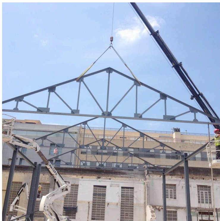
Figura 4.12 – Colocação das treliças
