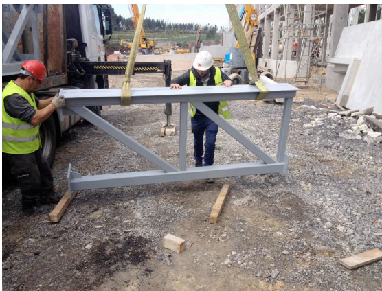
Figura 4.16 – Colocação da treliça
