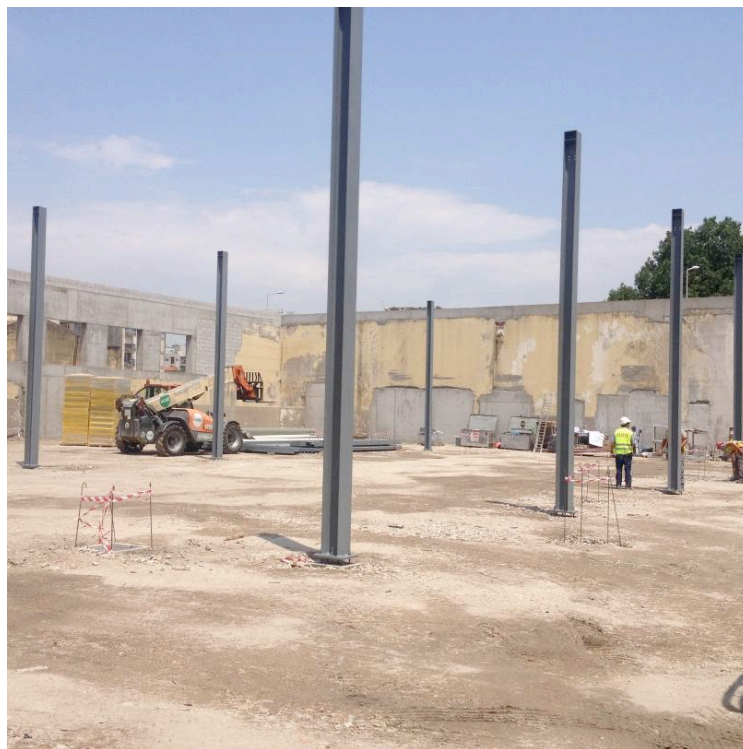
Figura 4.10 – Pilares prontos para receber as treliças
