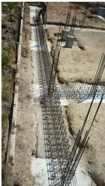
Figura 2.4 – Armaduras dos lintéis antes da betonagem [Fotografia fornecida pela empresa]
