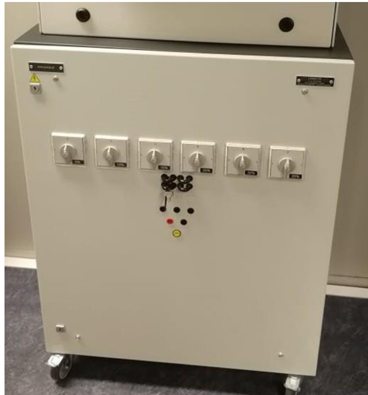
Figura 16 - Carga resistiva de 8kW.
