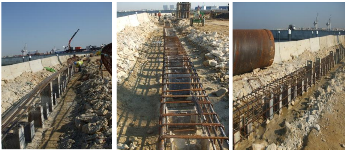
Ilustração 103 - Sequencia de execução da armadura
