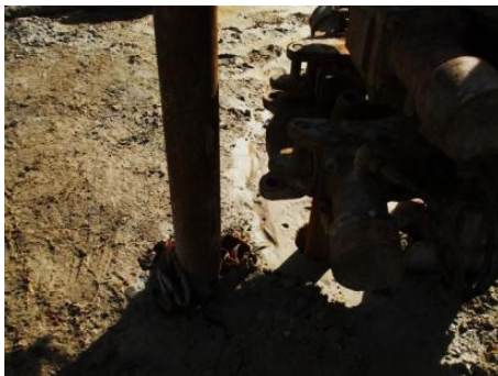
Ilustração 67 - Colocação do tubo
