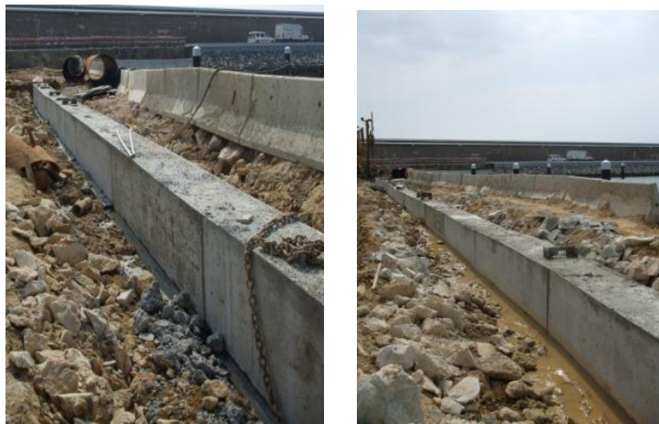
Ilustração 107 - Viga de coroamento executada
