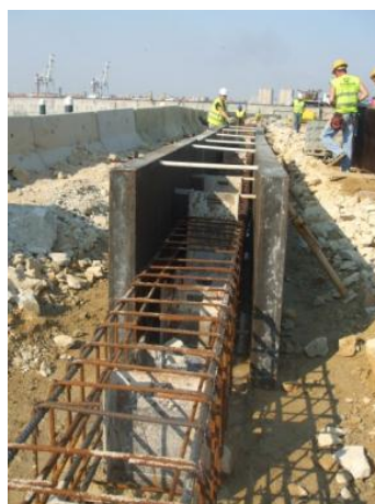
Ilustração 104 - Cofragem da Viga de Coroamento
