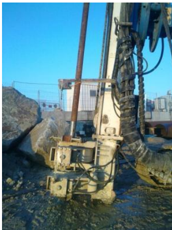
Ilustração 123 - Ensaio do Jet-grouting
