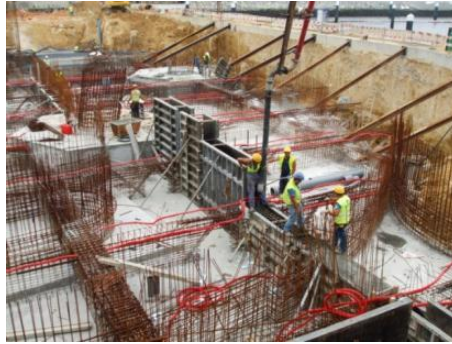
Ilustração 184 - 2ª Fase de escoramento
