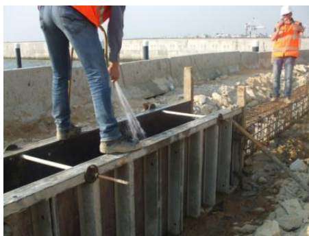
Ilustração 105 - Lavagem da armadura
