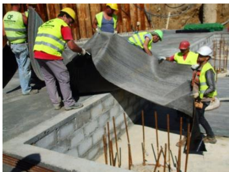
Ilustração 141 - Colocação da manta
