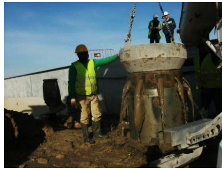
Ilustração 43 - Fim da betonagem
