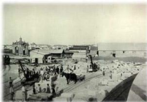
Ilustração 5 - Estaleiro de construção dos blocos artificiais do molhe Norte[2]
