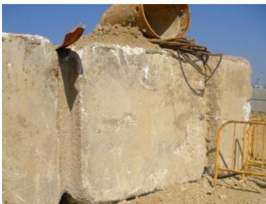
Ilustração 24 - Amostras de blocos de enrocamento
