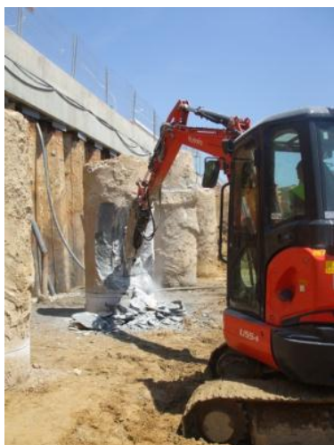
Ilustração 47 - Máquina a executar saneamento
