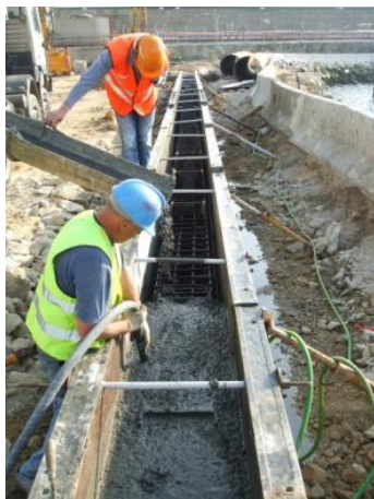
Ilustração 106 - Betonagem e vibração
