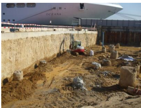
Ilustração 180- Escavação à cota 0
