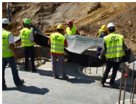
Ilustração 142 - Colocação da manta 2
