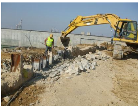
Ilustração 102 - Saneamento dos topos dos painéis
