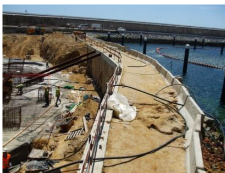
Ilustração 183- 1ª Fase de escoramento
