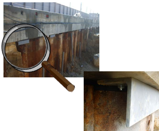
Ilustração 186 – Pormenor da aba metálica
