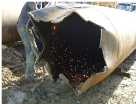
Ilustração 53 - Soldador a cortar o tubo danificado pelo enrocamento
