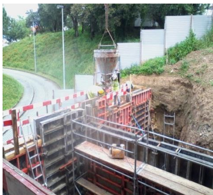
Figura 4.15 – Betonagem das paredes dos muros M1.1,
