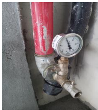
Figura 4.6 – Ensaio à pressão de carga na rede de incêndio
