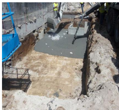
Figura 4.20 – Execução de poços de fundação - EMPREENDIMENTO 2
