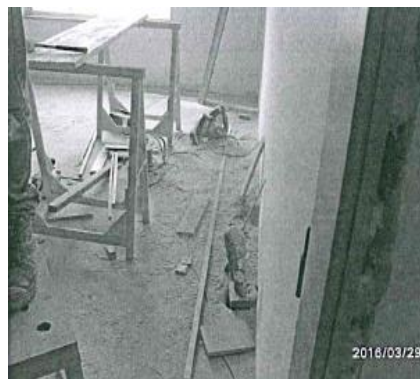
Figura 4.33 – Limpeza e ventilação das frentes de trabalho
