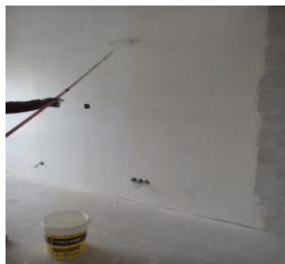
Figura 4.4 – Aplicação do primário nas paredes do piso 3
