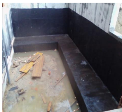
Figura 4.16 – Pintura asfáltica nos elementos
