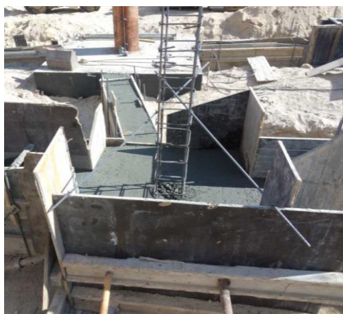
Figura 4.25 – Travamento da armadura do pilar
