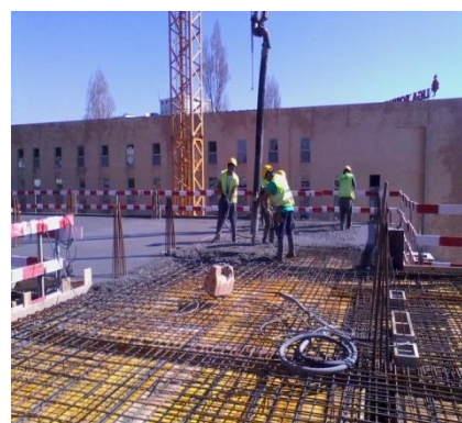
Figura 4.12 - Betonagem da laje do piso 3 - EMPREENDIMENTO 2
