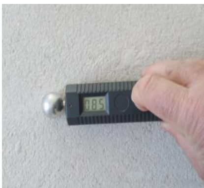
Figura 4.5 - Ensaio ao teor de humidade nas betonilhas
