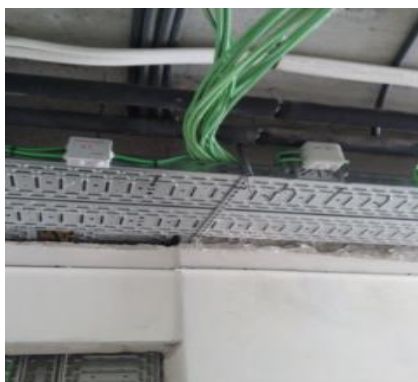
Figura 4.3 - Assentamento de caixas, tubagens de eletricidade e caminhos de cabos
