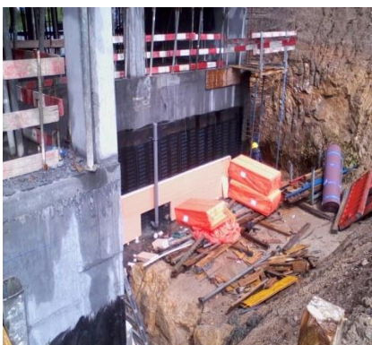
Figura 4.11 - Isolamento dos muros - EMPREENDIMENTO 2
