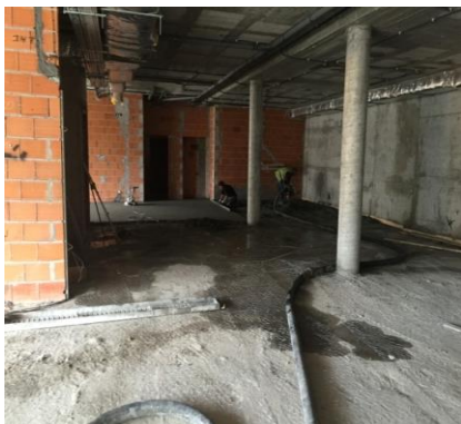
Figura 4.1 - Enchimento e incorporação de rede de galinheiro no pavimento do piso -1
