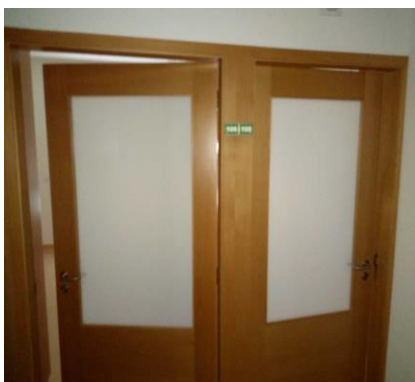
Figura 4.13 – Mainel e bandeira a ladear portas envidraçadas PM6 dos quartos individuais - EMPREENDIMENTO 1
