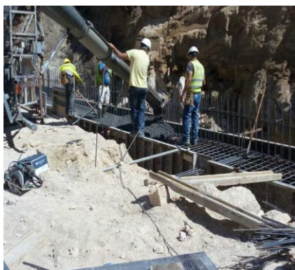
Figura 4.19 - Aplicação e compactação do betão na sapata do muro M14 - EMPREENDIMENTO 2
