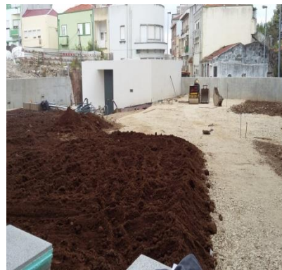
Figura 4.10 – Aplicação de tout-venant e terra vegetal, no exterior - EMPREENDIMENTO 1
