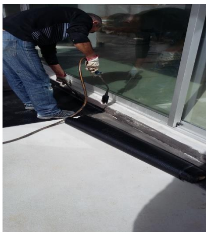
Figura 4.28 – Colocação da tela asfáltica sobre a laje do piso -2
