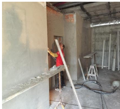
Figura 4.2 – Aplicação de reboco projetado nas paredes o piso -1
