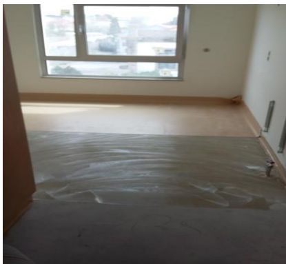
Figura 4.9 – Aplicação da cola e posterior assentamento de vinílicos, nas zonas secas - EMPREENDIMENTO 1
