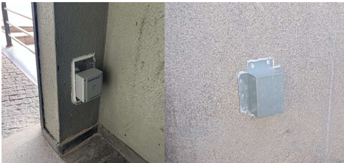
Figura 26- Sismógrafos em estruturas de edifícios.
