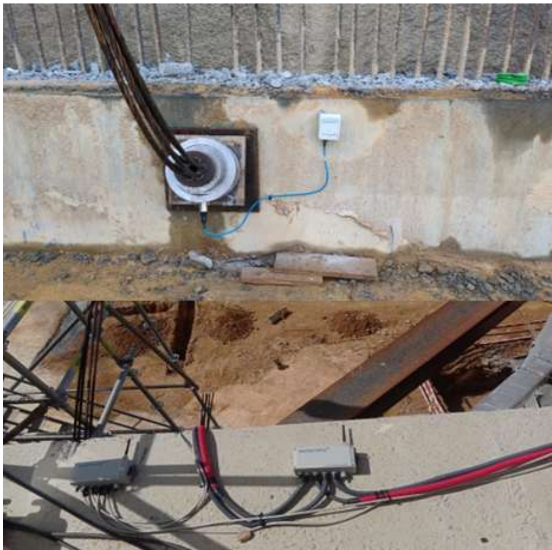
Figura 25- Célula de carga em estaca e respetivos recetores de sinal.
