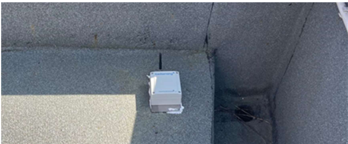
Figura 24- Clinómetro na horizontal, na cobertura de um edifício.
