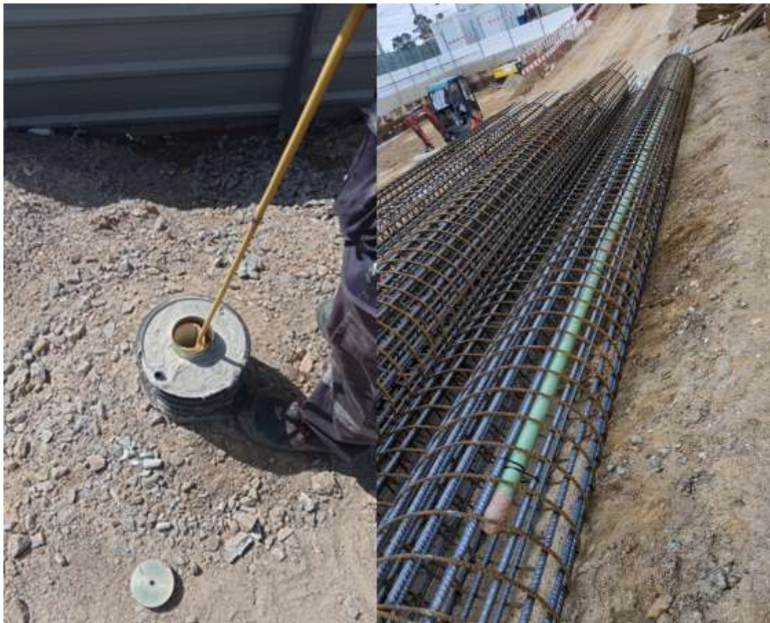
Figura 20- Medição com o torpedo (esquerda). Tubos inclinométricos dentro da armadura metálica de estaca moldada in situ (direita).
