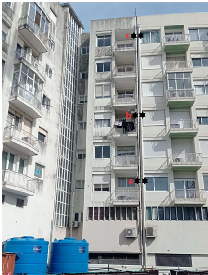
Figura 42- Esquema representativo da disposição de Prismas de Edifícios na junta dos edifícios E05A e E06A.
