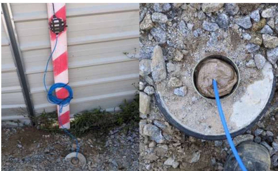
Figura 8- Instalação de um piezômetro de corda vibrante.
