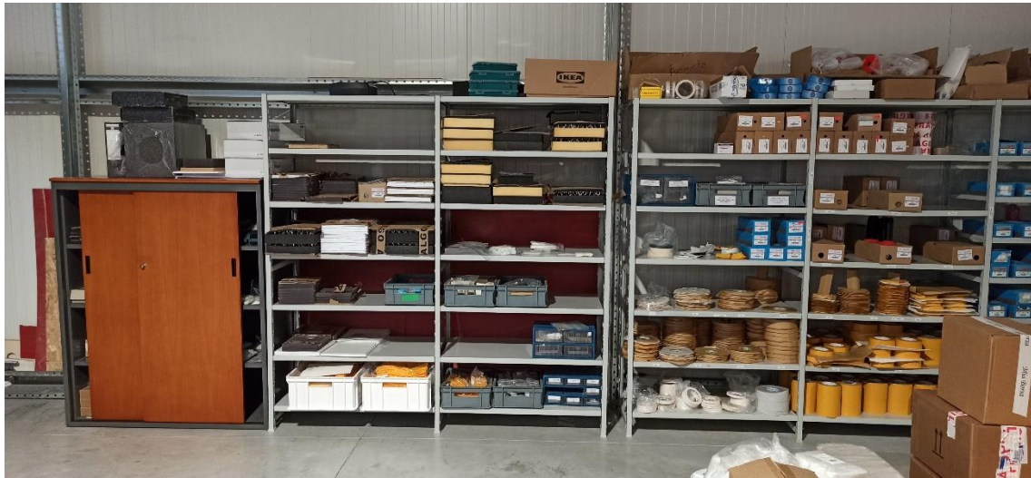
Figura 16 - Antes - Estante de Peças Metálicas
