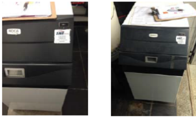
Figura 6 – Diversas Caldeiras do Edifício
