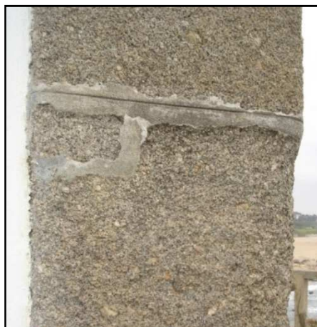
Figura 10 – Utilização de argamassa de cimento para o preenchimento de juntas e fendas (Maio, 2007).
