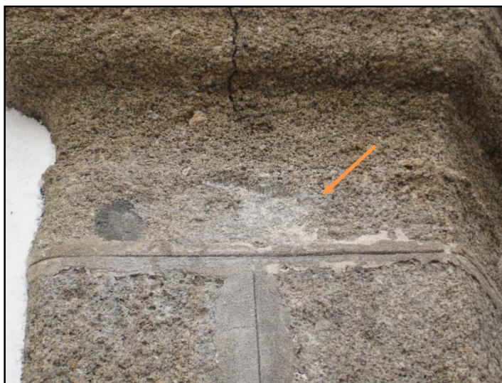
Figura 14 – Pilastra Sudoeste após a extracção do tarolo CSP 13 (Setembro 2007).
