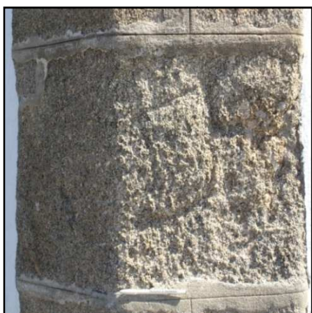
a) Pilastra Oeste
