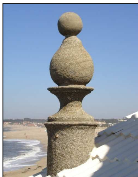
Figura 11 – Utilização de argamassas de cimento na substituição do granito (Setembro, 2007).
