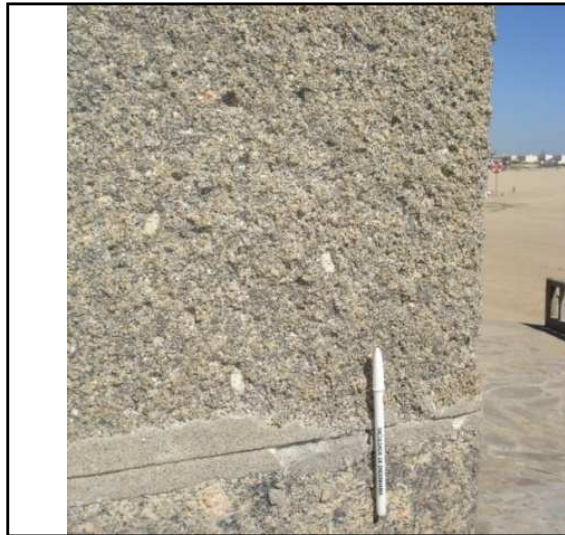
a) Pilastra Sul (Maio, 2007)
