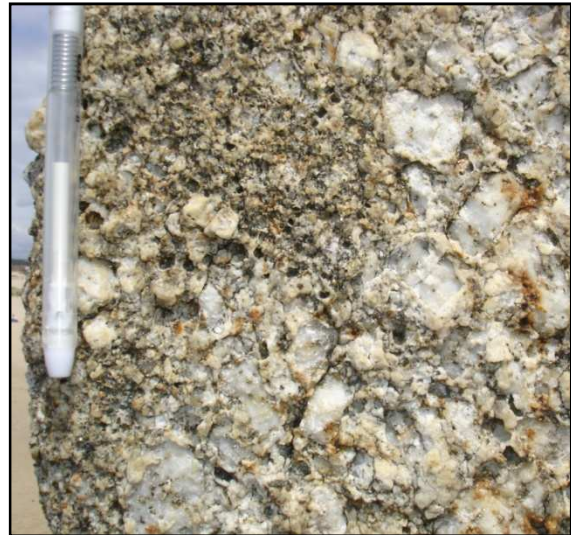
b) Pilastra Noroeste (Maio, 2008)
