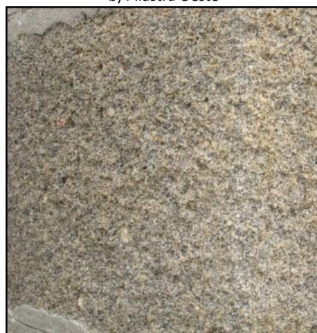
d) Pilastra Sul
