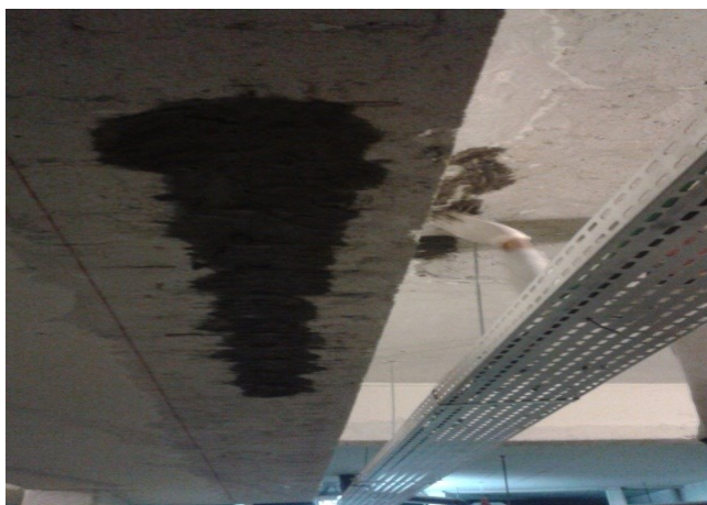
Figura 80 - Recuperação da superfície com argamssa polimérica
