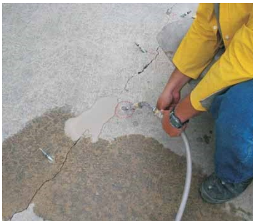
Figura 21 - Injeção de fissuras
