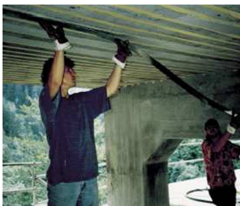
Figura 6 - Reforço de laje com lâminas de fibra de carbono
