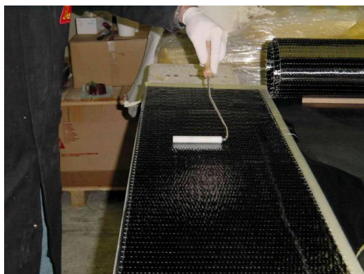
Figura 55 - Impregnação do tecido de fibra de carbono
