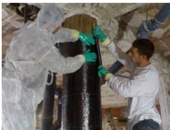
Figura 31 - Reforço por encamisamento de pilar
