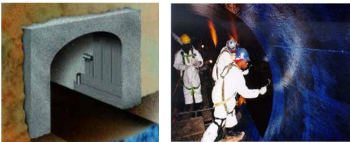
Figura 33 - Reforço interior de túneis
