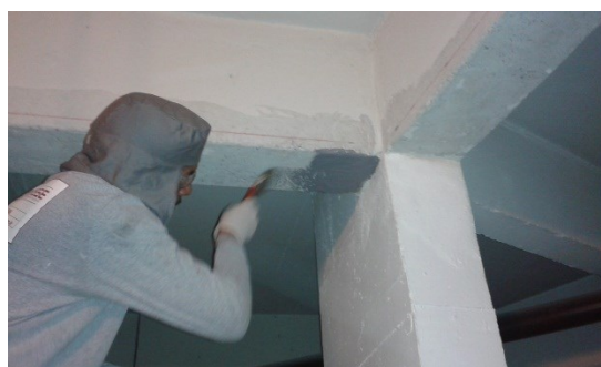
Figura 23 - Aplicação da primeira camada de adesivo
