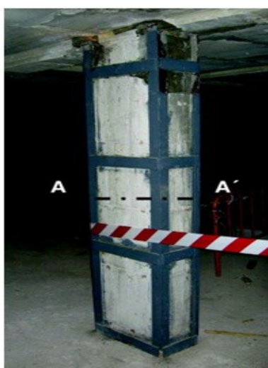
Figura 5 - Pilar com armadura metálica de reforço
