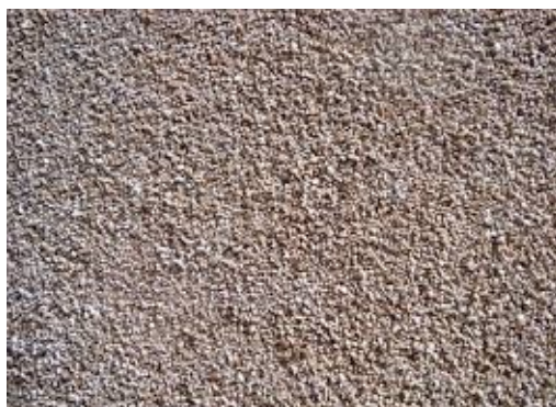
Figura 41 - Superfície de revestimento de vermiculite
