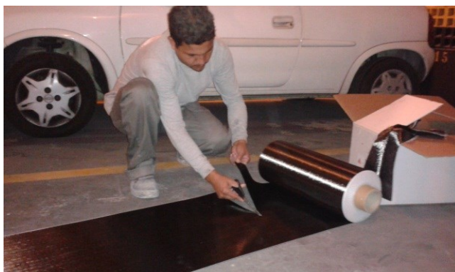
Figura 81 - Corte do tecido de fibra de carbono
