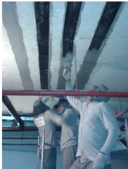
Figura 26 - Aplicação da segunda camada de adesivo
