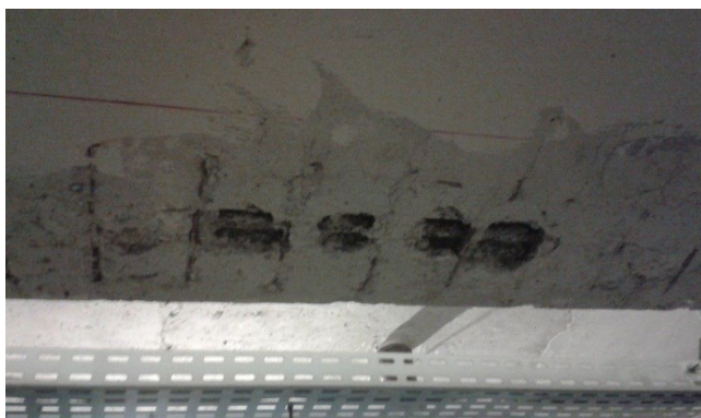
Figura 79 - Remoção da leitada de cimento para recuperação da superfície
