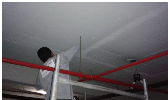
Figura 76 - Inspeção dos elementos a reforçar
