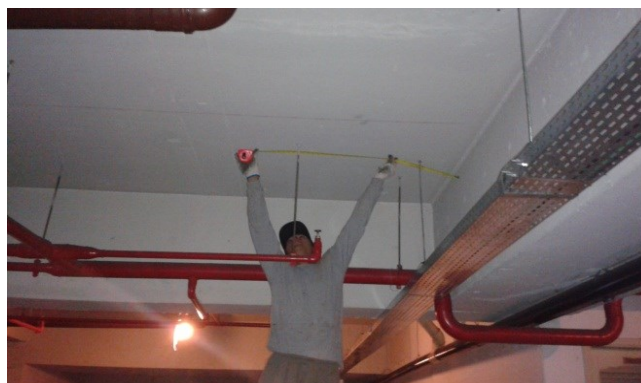
Figura 77 - Marcação da área de lixagem
