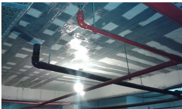
Figura 86 - Resultado final de reforço
