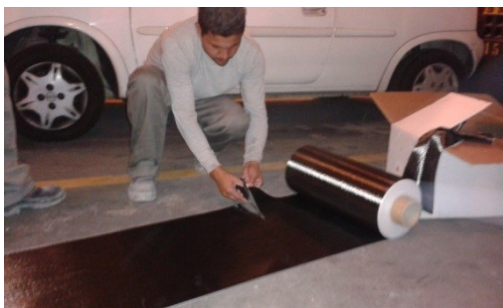
Figura 24 - Corte da fibra para aplicação conforme projeto
