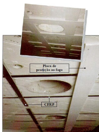
Figura 42 - Placas de gesso sobre o CFRP
