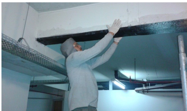
Figura 83 - Aplicação do tecido de fibra de carbono
