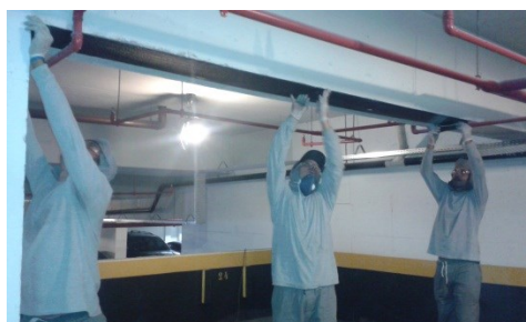
Figura 25 - Aplicação da fibra de carbono na superfície
