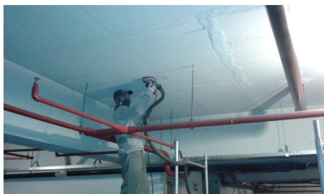
Figura 78 - Lixagem da superfície a reforçar
