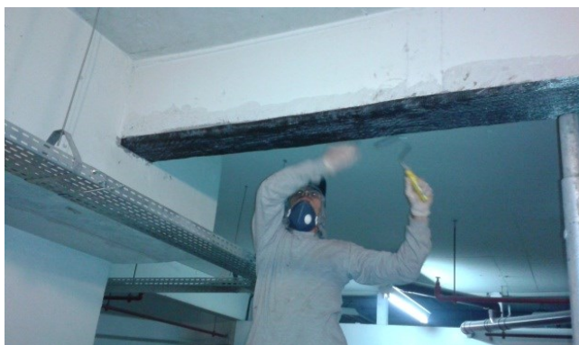
Figura 84 - Melhoria de aderência com rolo plástico
