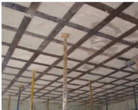
Figura 4 - Laje com armadura metálica de reforço
