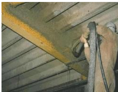
Figura 44 - Projeção de argamassa com fibras minerais
