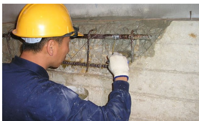
Figura 20 - Recuperação da superfície de betão e armaduras
