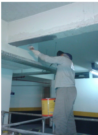
Figura 82 - Aplicação da 1ª camada de adesivo
