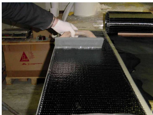
Figura 56 - Remoção de adesivo excedente
