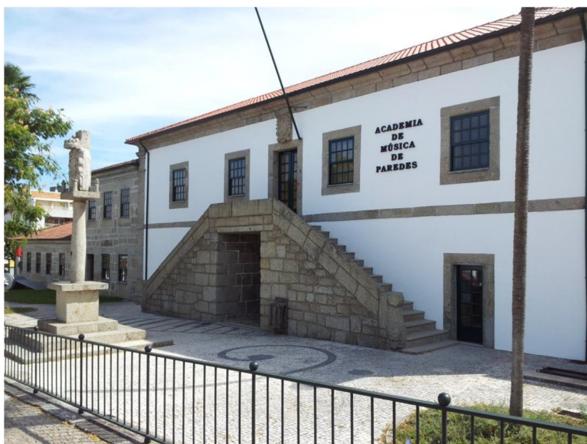
Imagem 1 – Conservatório de Música de Paredes
