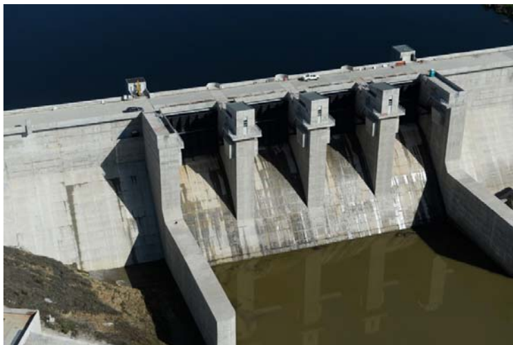
Figura 8 Escalão de Jusante: fase final de construção. Betão Gravidade assente em xisto. 45m de altura, 21 blocos. Vista de jusante para montante. (Foto: EDP,2014)
