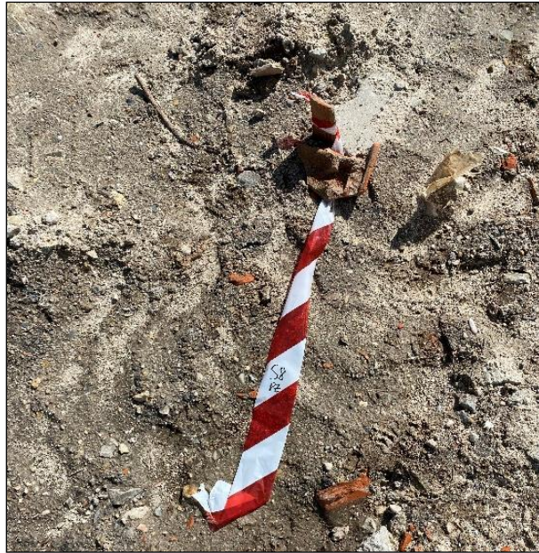
Figura 20: Marcação dos pontos de prospeção (Imagem Mota-Engil).
