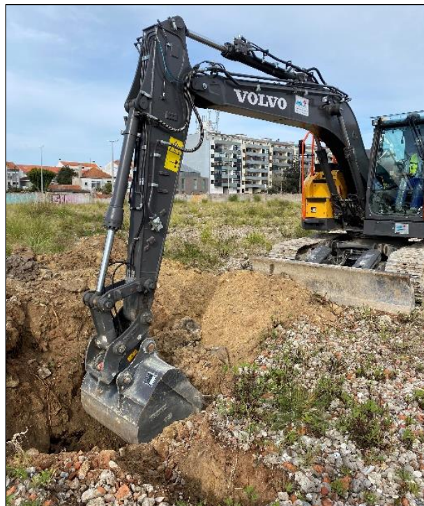
Figura 22: Execução do poço de prospeção. (Imagem Mota-Engil).
