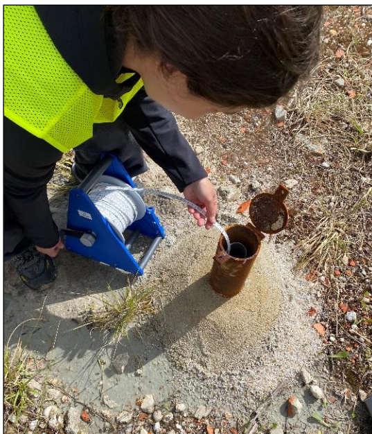
Figura 23: Monitorização dos piezómetros. (Imagem Mota-Engil).
