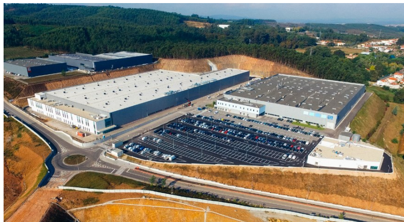
Figura 8 - Vista das duas fábricas WEG de Santo Tirso, Portugal. (fonte: WEG)
