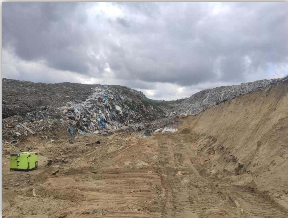
Figura 22. Escavação realizada para remediação do problema de deposição de resíduos (foto tirada por autor, 06/07/2021).
