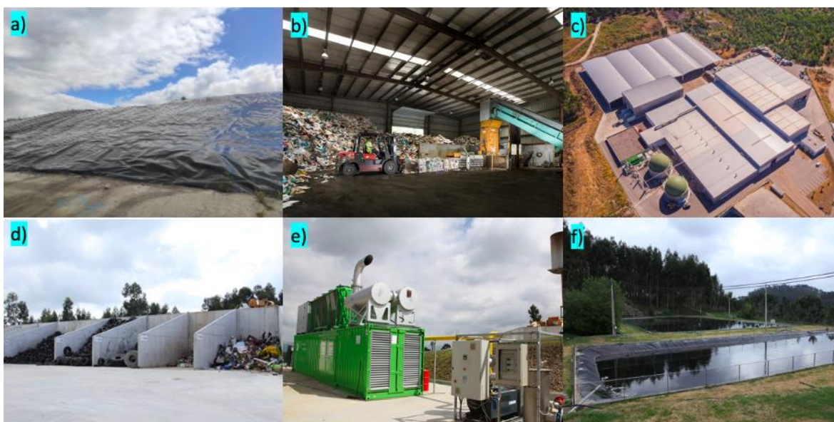
Figura 17. Instalações ecoparque Braval, em que: a) Aterro sanitário; b) Estação de triagem; c) Unidade de tratamento mecânico e central de valorização orgânica; d) Ecocentro; e) Unidade de valorização de biogás; f) Estação de tratamento de lixiviados.
