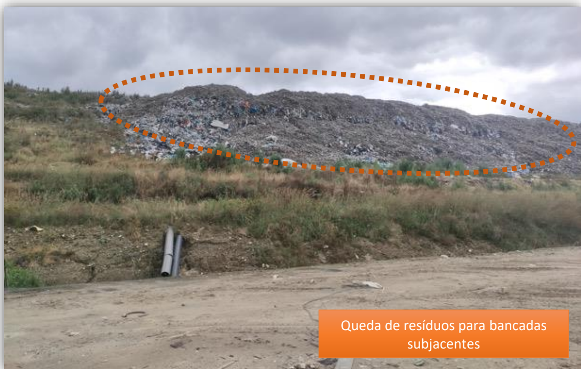
Figura 31. Queda de resíduos entre bancadas na célula 2 (foto tirada por autor, 06/07/2021).
