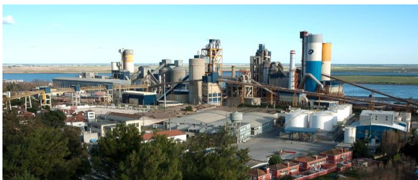
Figura 14 - Fábrica de cimento com funcionalidade de coprocessamento [37]
