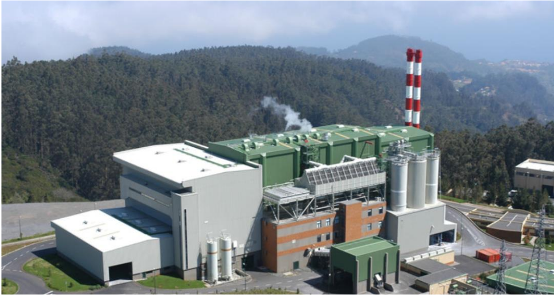
Figura 12 - Incineradora Municipal de Resíduos Sólidos – Ilha da Madeira [30]
