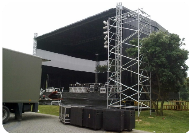
Fotografia 5 – Montagem de estrutura para suspensão do line array (fotografia de Diogo Leichsenring Franco, tirada no dia 25 de Julho de 2014).
