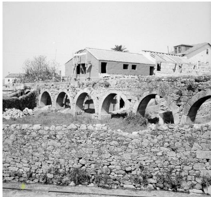
Figura 12 - Aqueduto de Coelho, Póvoa de Varzim (In http://www.monumentos.gov.pt/Site/APP_PagesUser/SIPA.aspx?id=5130 )
