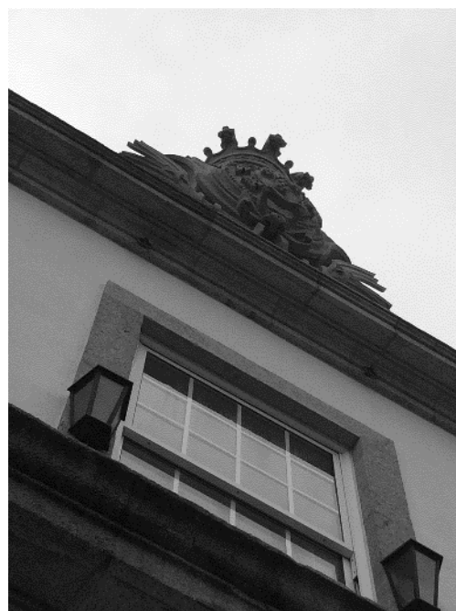
Figura 6 - Enfiamento da janela superior com o brasão de armas e coroa real, destacando-se a cornija em granito que remata a cobertura. Registo de Maria Antónia Bacelar.
