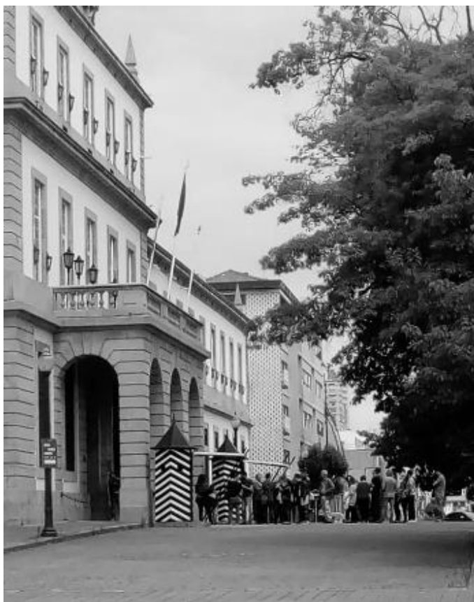
Figura 1 - A aproximação ao edifício do Quartel de Santo Ovídio – Porto. Registo de Maria Antónia Bacelar.
