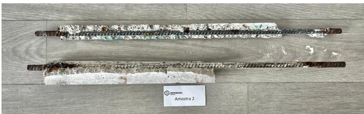
Figura 6.15 - Varões de aço retirados dos provetes da amostra 2, no qual a sua cura foi realizada em água do mar
