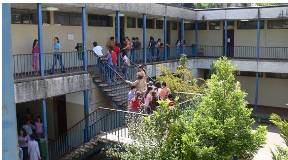
Figura 8 - Acesso entre pavilhões da escola sede do Agrupamento
