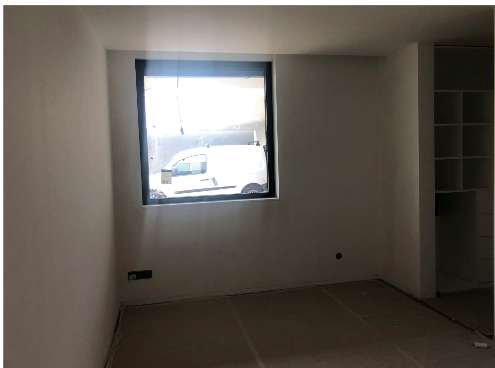
Figura 161- Fotografia de obra da suite Rita
