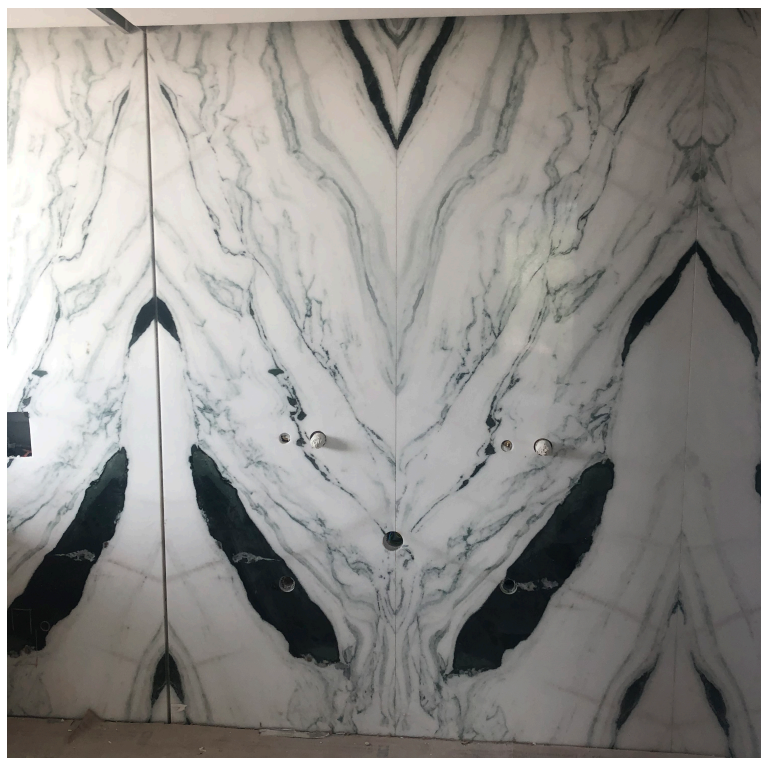
Figura 169 - Fotografia de obra da casa de banho casal
