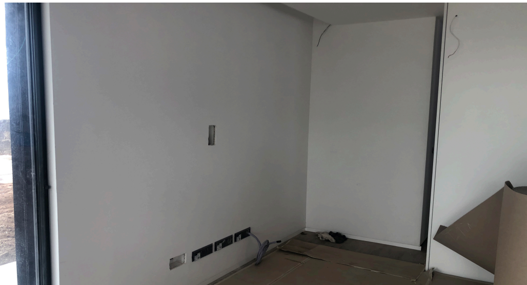
Figura 146 - Fotografia de obra da sala
