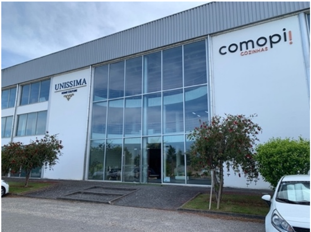
Figura 114 - Instalações Comopi e Unísssima
