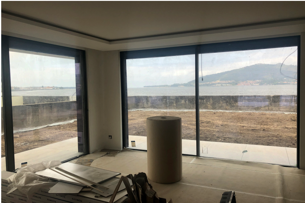
Figura 145 - Fotografia de obra da sala
