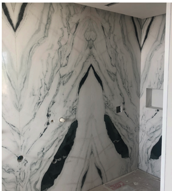
Figura 170 - Fotografia de obra da casa de banho casal
