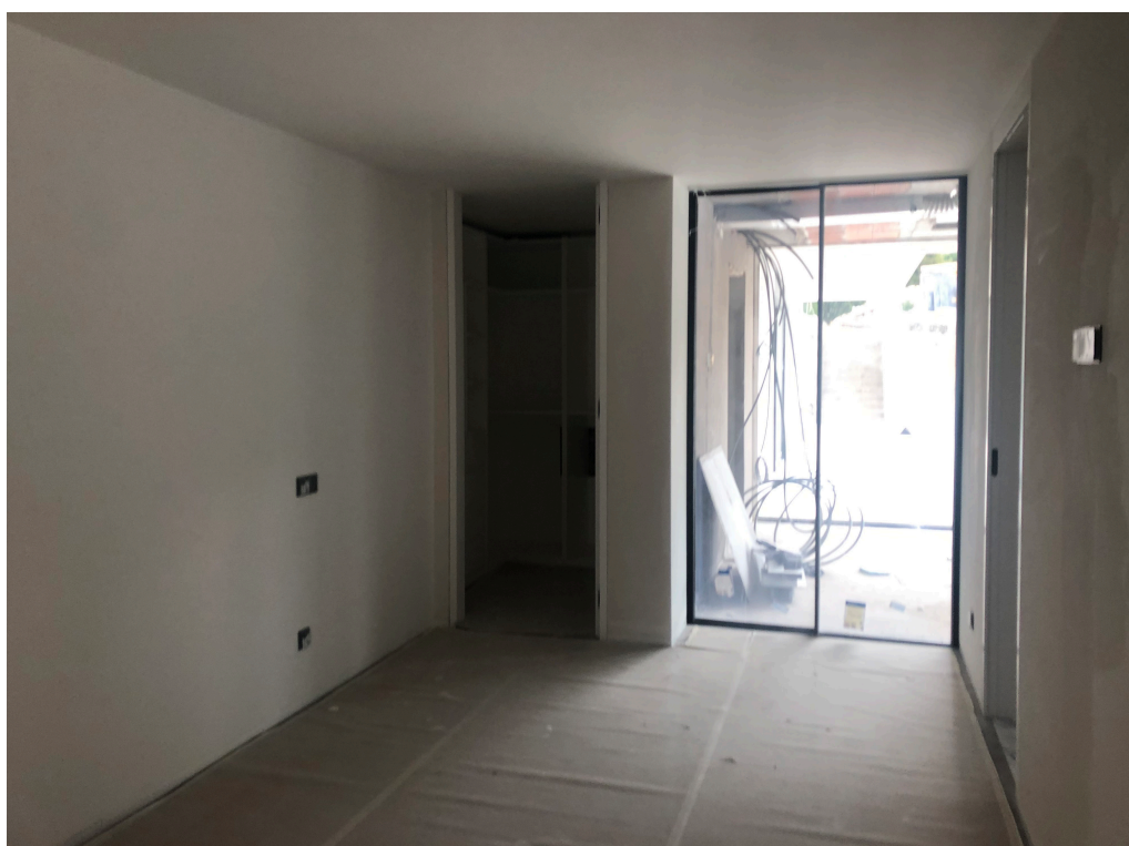
Figura 155 - Fotografia de obra da suite Rodrigo
