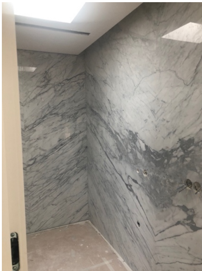
Figura 172 - Fotografia de obra da Casa de banho Social
