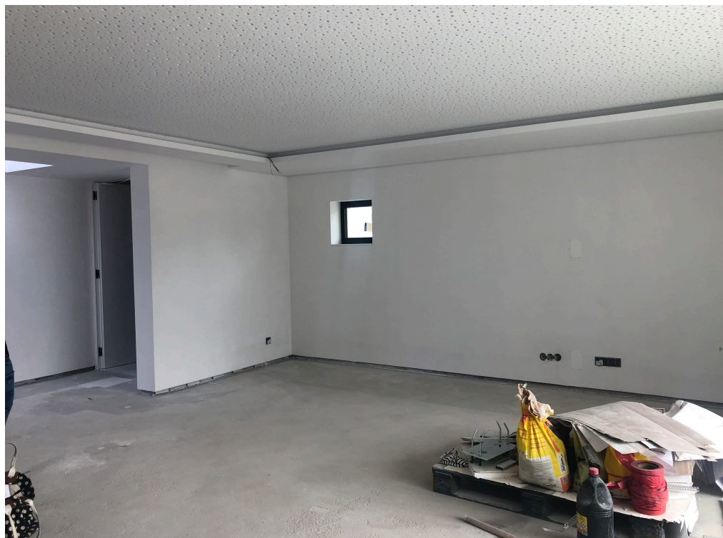
Figura 148 - Fotografia de obra da sala de jogos
