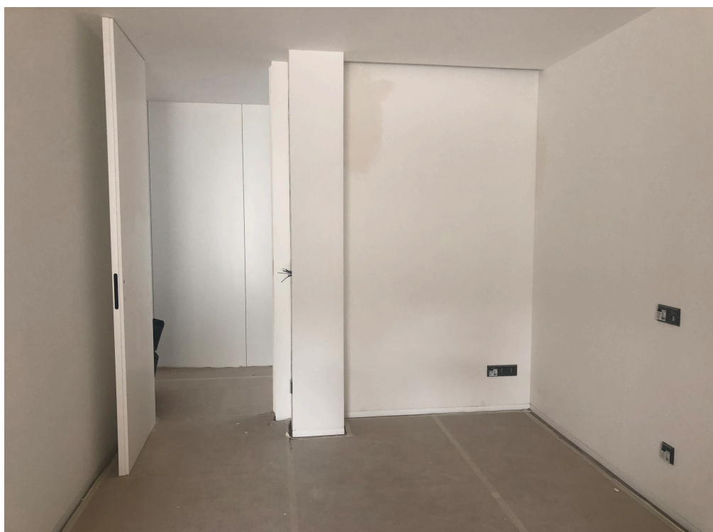
Figura 154 - Fotografia de obra da suite Rodrigo
