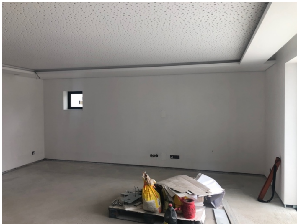
Figura 149 - Fotografia de obra da sala de jogos
