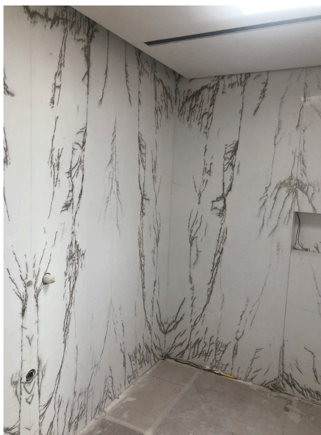
Figura 164 - Fotografia de obra da casa de banho Rita
