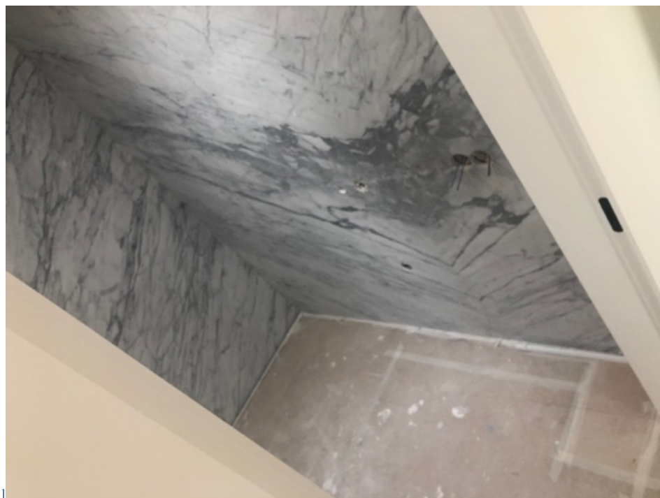
Figura 173 - Fotografia de obra da casa de banho casal
