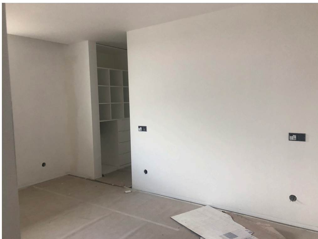
Figura 160 - Fotografia de obra da suite Rita
