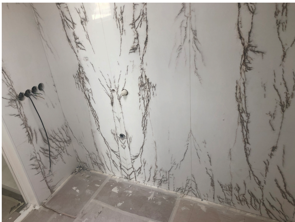
Figura 163 - Fotografia de obra da casa de banho Rita
