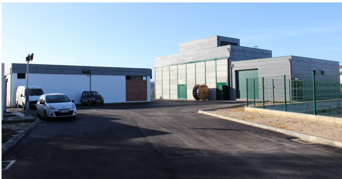
Figura 6 Subestação de Energia de Parceiros 60/15 kV, Leiria, Fevereiro de 2014
