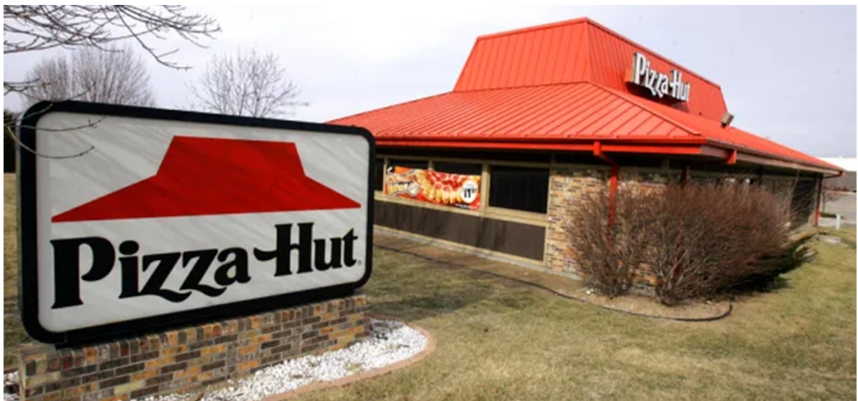
Figura 4 – O telhado dos estabelecimentos da Pizza Hut que constitui o 5º elemento da marca. Fonte: “ www.thehill.com/homenews/nexstar_media_wire/3547958-the-architect-who-designed-pizza-huts-red-roof-restaurants-made-a-ton-of-money-thanks-to-an-unusual-deal/ ”
