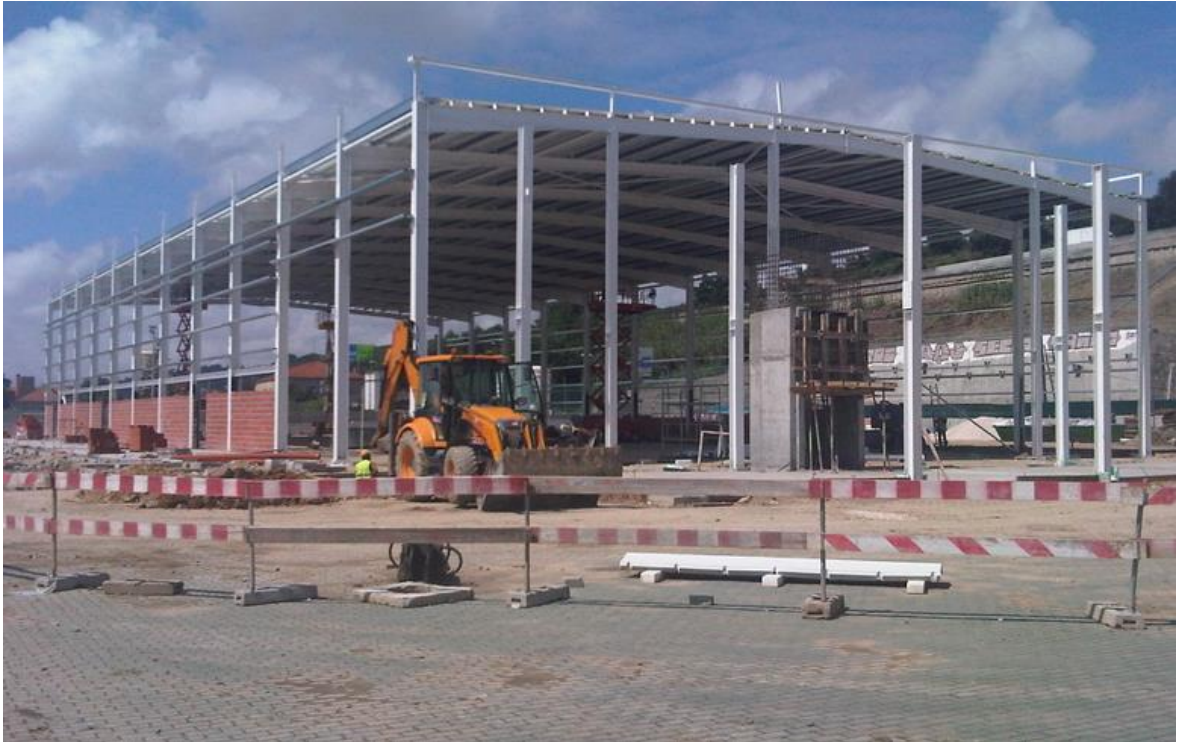
Figura 1.6 – Pavilhão Multiuso do Cevadeiro (Vila Franca de Xira) – Foto 1
