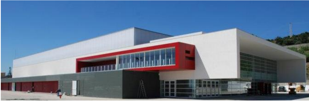
Figura 1.8 – Pavilhão Multiuso do Cevadeiro (Vila Franca de Xira) – Foto 3
