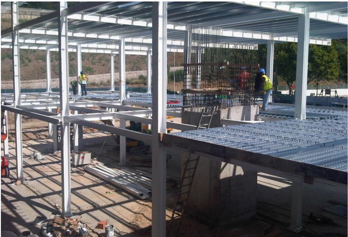
Figura 1.7 – Pavilhão Multiuso do Cevadeiro (Vila Franca de Xira) – Foto 2
