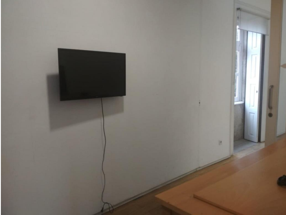
Fig.16 - Montagem da estrutura e colocação do ecrã.
