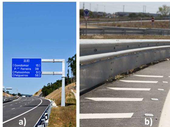
Figura 10 - (a) Pórticos; (b) Guardas de segurança
