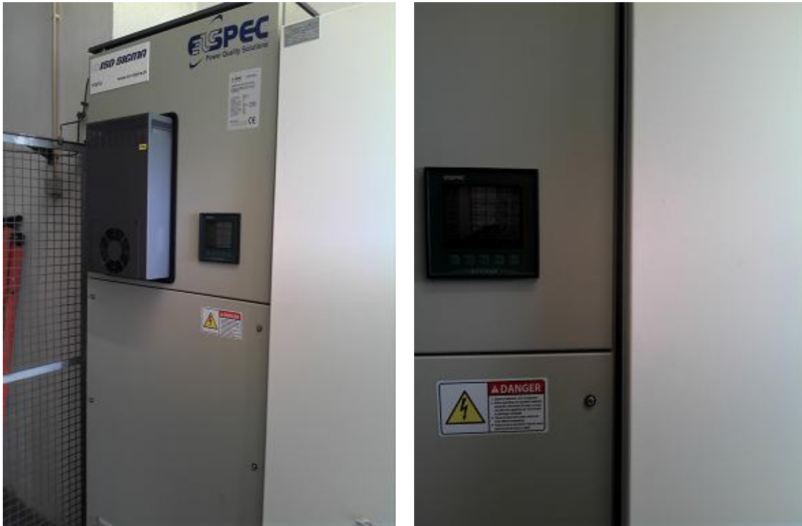
Fig. 7.7 - Limitação de espaço existente no local.
