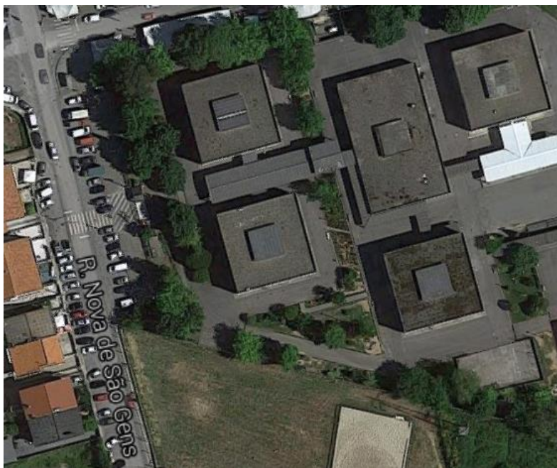
Vista aérea da Escola Básica de Custóias. Fonte: (Google Maps).
