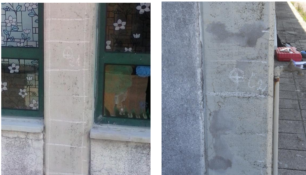
Figura 6.40 – Marcação nos Pilares: G3 (à esquerda) e G2 (à direita).
