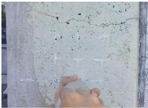
Figura 6.35 - Marcação de pontos para ensaio.
