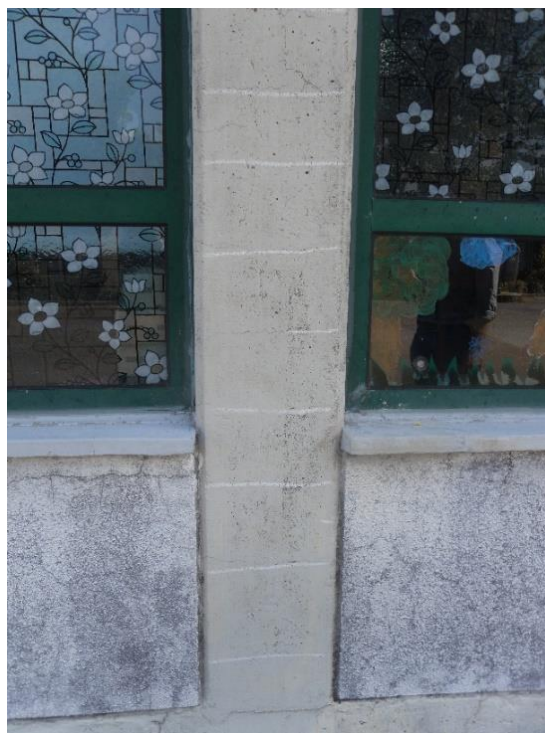
Figura 6.32 – Marcação das armaduras do Pilar G3.
