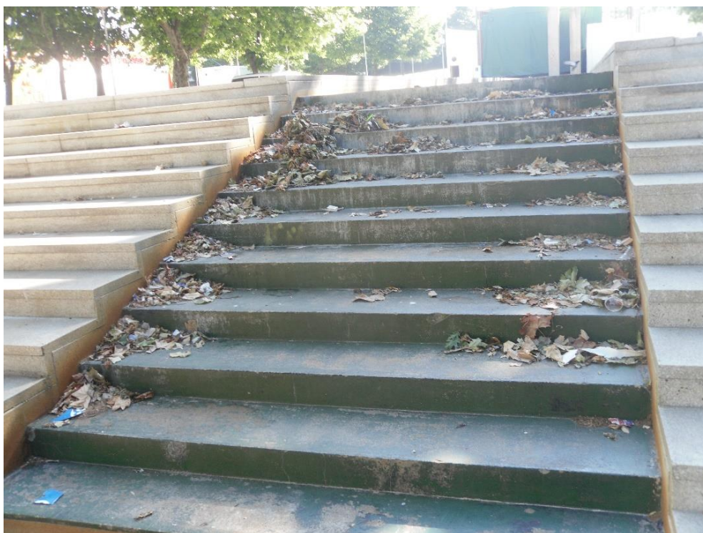
Figura 9 - Escadas do Corpo 2.
