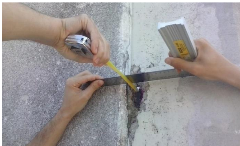
Figura 6.18 - Medição de profundidade de carbonatação.
