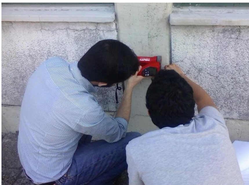
Figura 6.31 - Marcação das armaduras com giz.
