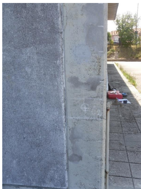
Figura 6.33 - Marcação das armaduras do Pilar G2.
