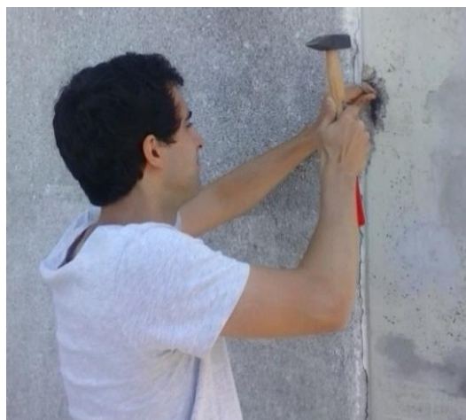
Figura 6.14 - Remoção superficial do betão.
