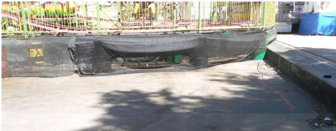
Figura 6 - Base do lago, próximo do murete a Norte.
